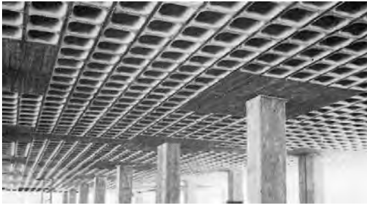
Ilustración 48. Losa Reticular o Nervada. Fuente: http://tecnicasenlaconstruccion.weebly.com/uploads/1/3/6/6/13669342/clase_3p_16nov_losa_de_concreto_armado.pdf [01-10-2015]
