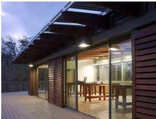
Ilustración 8. Fachada de la Preparatoria de Hawái. Fuente: http://www.archdaily.mx/mx/02-74028/edificio-de-ciencias-de-preparatoria-de-hawaii-flansburgh-architects [22-09-2015]
