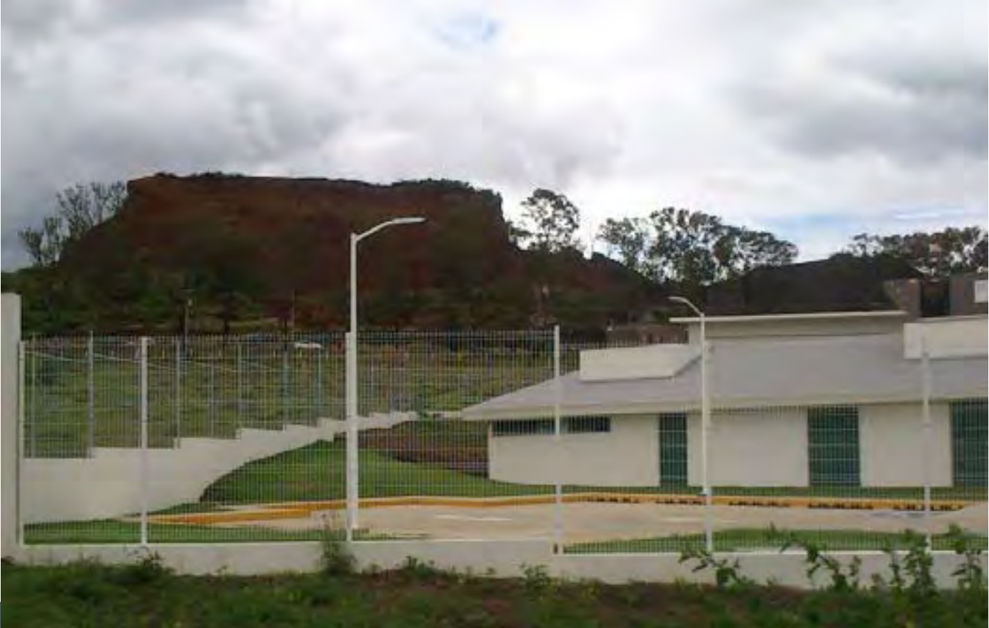
A39. Análisis fotográfico, construcción HRZ en terreno. Fuente: Autor, Karen García.
