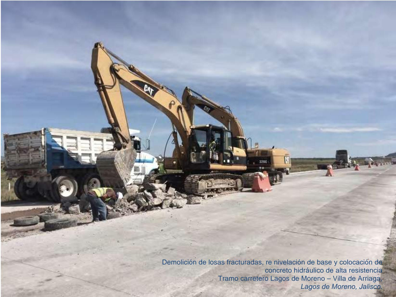
Demolición de losas fracturadas, re nivelación de base y colocación de
