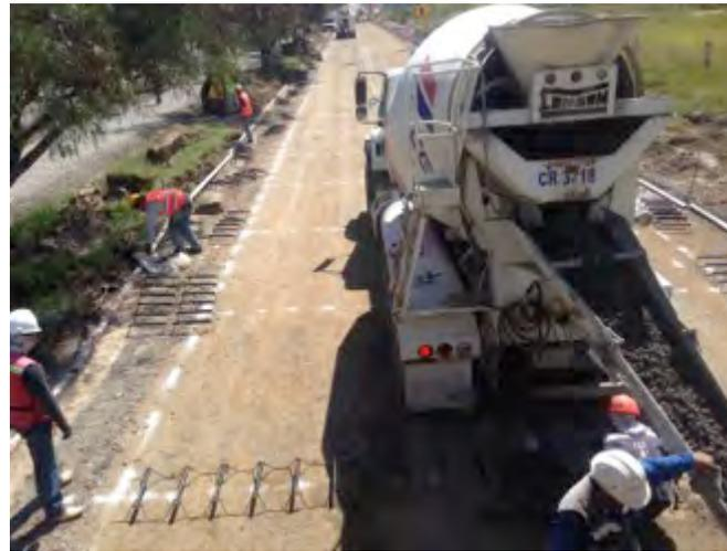
**IMAGEN III.5.3.2** Colocación de barra pasajunta previo al tendido del concreto hidráulico.
