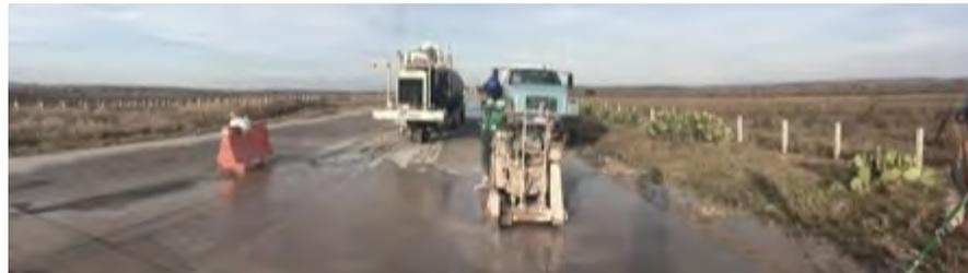
**IMAGEN III.1.1** Corte para demolición y fresado de losa, Autopistas Guadalajara – Tepic
