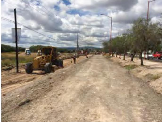
**IMAGEN III.5.3.1** Tendido de subrasante para ampliación de tercer carril
