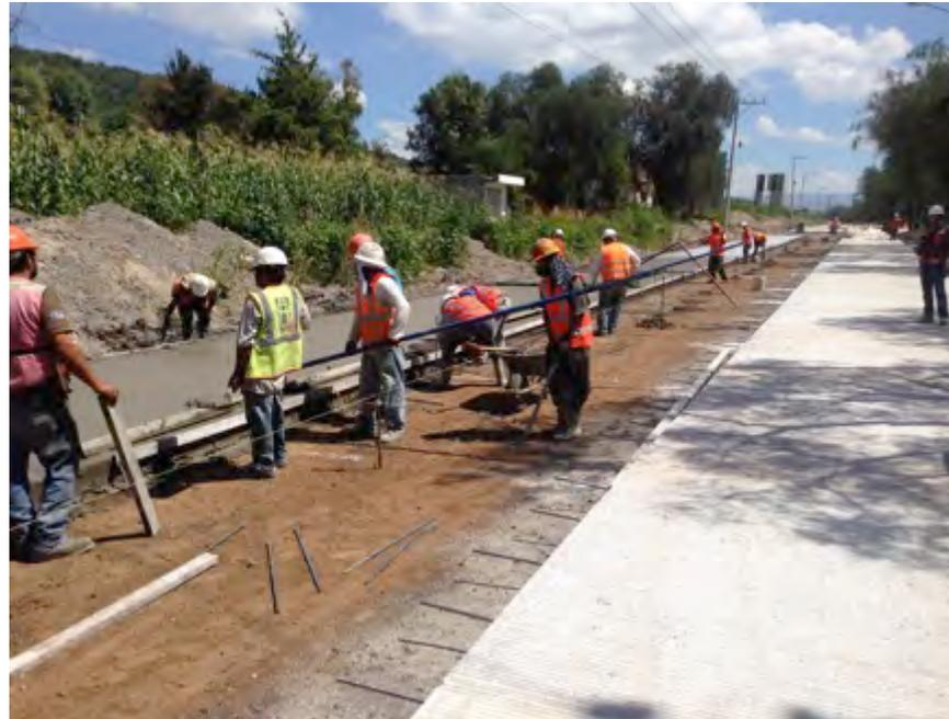
**IMAGEN III.5.3.3** Colado de la segunda franja con cimbra deslizante (maquina pavimentadora).
