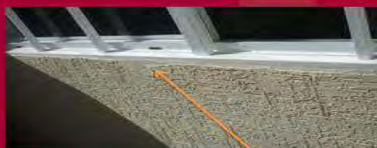
Mal perfilado de pasta junto a cancelería
