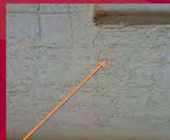
Fisura en cerramiento inferior de ventana
