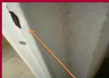
Por los descadres de la puerta de patio, doblan aluminio para corregir
