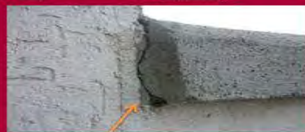
Moldura de muros de patio fisurados
