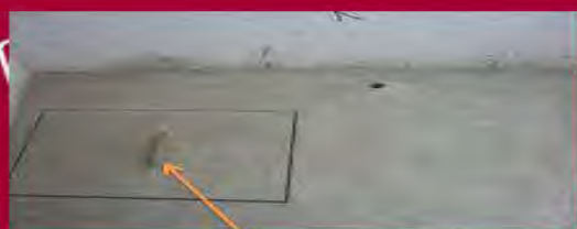
Algunas tapas de registro tienen jaladera otras no. UNIFORMIZAR
