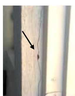
Ilustración 20 detalles de fisuras y juntas fuente autor
