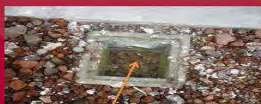
Limpieza de areneros y colocación de rejillas
