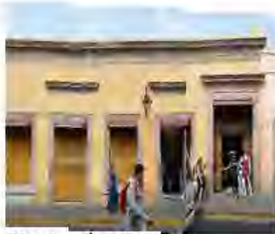
Posible Fotografía del inmueble Fotografía no. 35 Vivienda en Valladolid No. 79, tomada por: Ruth Evelyn Fuentes Alcaraz.
