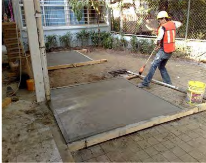
Ilustración 19 Firme con Malla Electrosoldada, FUENTE: Obras en mi Ciudad, http://www.obrasenmiciudad.df.gob.mx/?p=3453 , 05/09/2013
