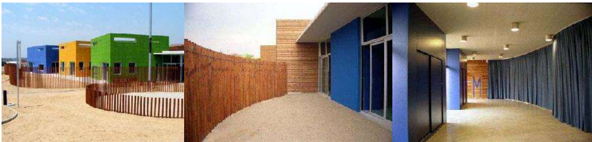
Aulas de la guardería Els Daus. (Arquimaster, 2005)
