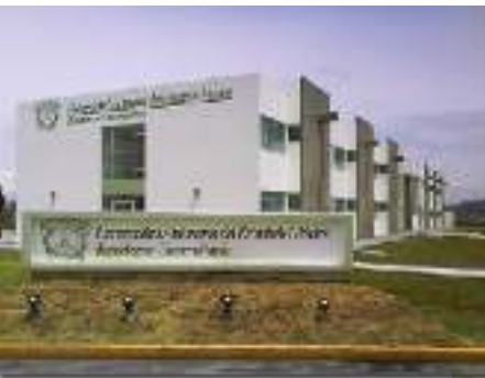
IMAGEN 42: FACHADA DE LA RESIDENCIA
