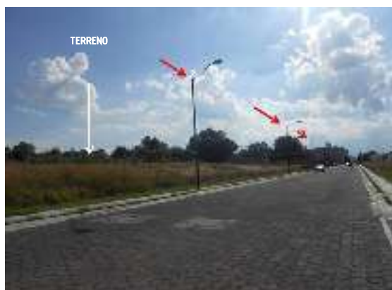
IMAGEN109: SE PUEDE OBSERVAR EL PREDIO Y LA ABUNDANCIA DE LÁMPARAS DE ALUMBRADO PÚBLICO A LO LARGO DE ÉL.
