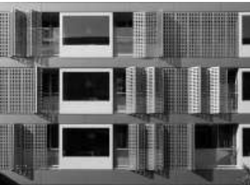
IMAGEN 30: FACHADA QUE PERMITE EL CONTROL DE LA LUZ
