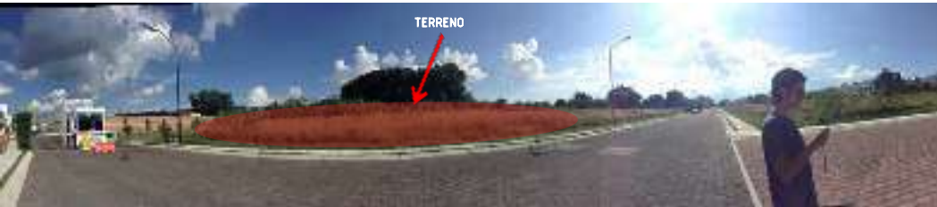
IMAGEN 107: SE PUEDE OBSERVAR EL PREDIO, LA CALLE SE ENCUENTRA URBANIZADA CON ADOQUINES, OBSERVAMOS IGUALMENTE LA BANQUETA CON SU GUARNICIÓN. AÚN NO HAY PLANTAS DE ORNATO NI RAMPAS PARA DISCAPACITADOS
