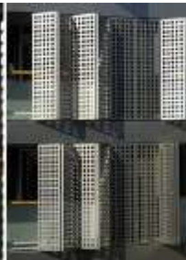
IMAGEN 31: EL CONTROL DE LA LUZ SE REALIZA POR MEDIO DE PANELES METÁLICOS
