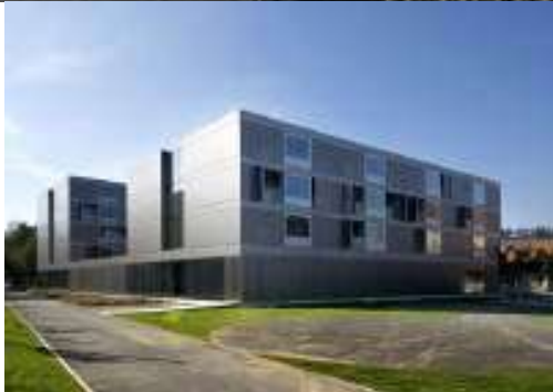
IMAGEN 32: PODEMOS OBSERVAR LOS DOS BLOQUES QUE CONFORMAN EL EDIFICIO, CONTENIENDO EL ESPACIO CENTRAL
