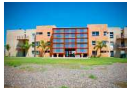
IMAGEN 39: FACHADA DE LA RESIDENCIA
