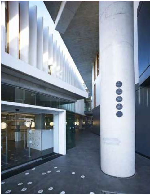
Figura 2.4 Bernardo J. (2012) Vista del área de pasillos Disponible en: http://www.archdaily.mx/mx/02-191026/casa-de-la-cultura-daniel-modol
