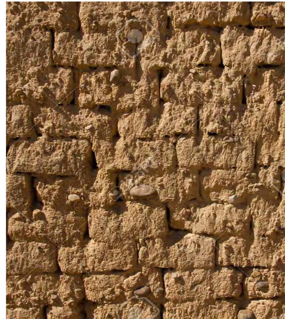
Figura 02. Muro de bloques de adobe. Tomada por Gerardo García Navarro
