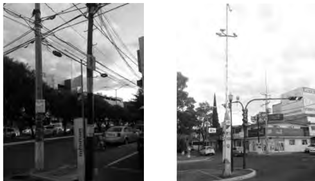
Imagen 50 Postes de CFE, TELMEX, semáforos vehiculares y casetas de teléfono. Autor: José Luis Tapia Ayala. Fecha: 10 Marzo 2016.
