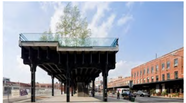
Imagen 79 Estructura de 9 metros de altura desde nivel de piso. El parque tiene 14 accesos en todo su recorrido. Fuente: http://laurbanacom/
