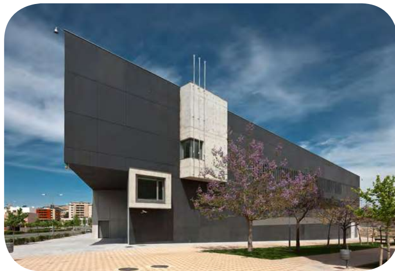
Imagenen 29.- Perspectivas del Edificio de Juzgados 1° Instancia de Tudela / Otxotorena [ http://www.archdaily.mx/mx/02-234772/juzgados-1-instancia-de-tudela-otxotorena ] Septiembre 2015
