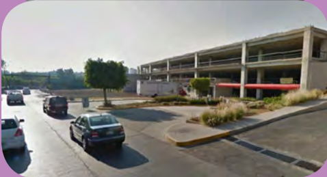
Imagen 61. Perspectivas del Edificio de la antigua Central Camionera., ahora estacionamiento, Fotografia tomada por J.F.R.Pacheco. Morelia, Michoacán Mexico. Septiembre 2015.
