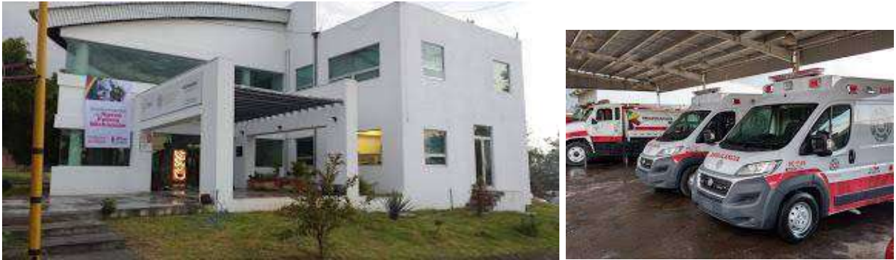
Fig.103 Protección civil Estatal de Michoacán, Morelia.
