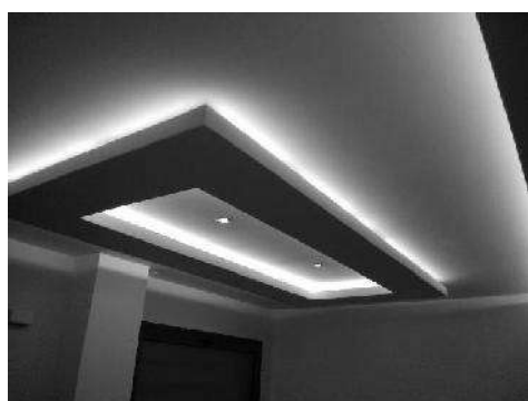
Fig.88 Plafón con Iluminación LED
