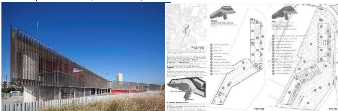
Fig.99 Parque central de bomberos, Mallorca..
