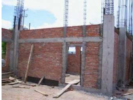
Imagen 19 castillos en muros
