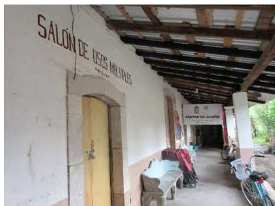
Fotografía 12 salón de usos múltiples estación de protección civil. (Fuente propia fecha 24-08-2016)
