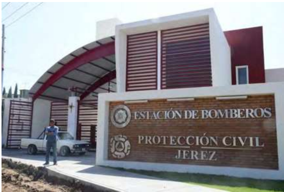
Imagen 27 fachada principal de estación de bomberos y protección civil Jerez Zacatecas https://www.google.com.mx/search?q=estacio
