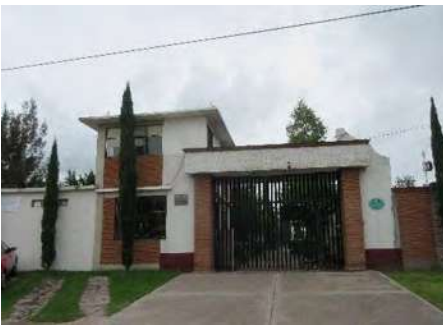
Fotografía 20 colegio de bachilleres Plantel Santa Ana Maya (fuente propia 24-08-2016)
