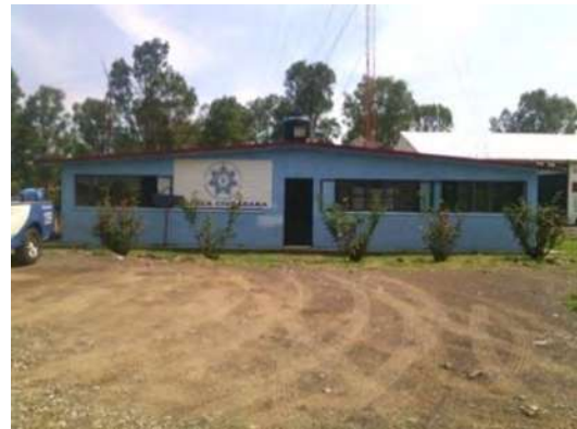
Fotografía 2 fachada principal estación de policías (Fuente propia. Fecha 07-02-2016)
