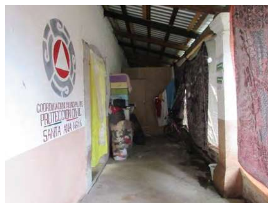
Fotografía 10 bodegas estación de protección civil. (Fuente propia fecha 24-08-2016)
