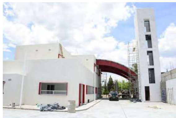
Imagen 28 vista lateral estación de bomberos y protección civil del municipio de Jerez. https://www.google.com.mx/search?q=estaci
