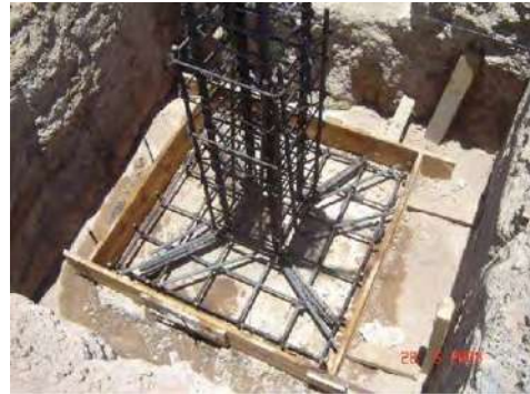
Imagen 17 cimentación zapata aislada (fuente
