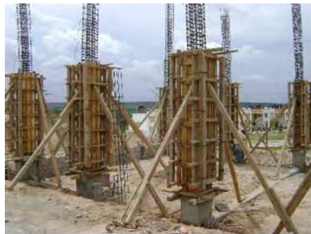
Imagen 18 columnas de concreto armado
