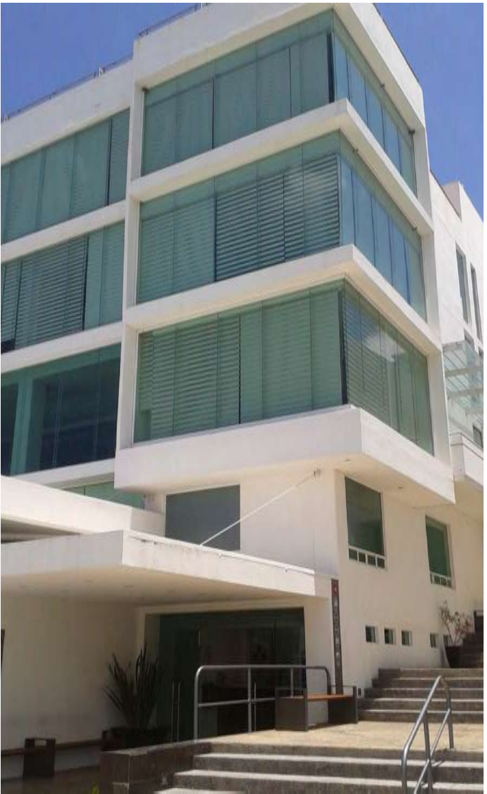
Fig. 40. Fachada del edificio administrativo. Foto: Luis Guzmán.
