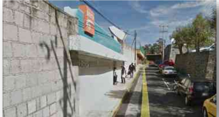
ACCESO PRINCIPAL (SMRT)
