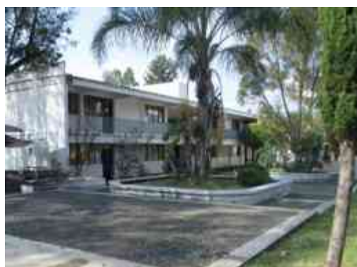
Imagen 3. Edificio E de la Facultad de Químico Farmacobiología de la UMSNH.
