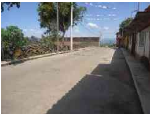
Imagen 86: imagen de la calle principal del predio señalando la ubicación de la red del drenaje. Fuente: Benjamín Cortes Sebastián. [3/Oct/2015]
