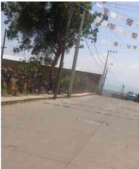
Imagen 90: Ubicación de la señalización de la red de la línea de telecomunicaciones. Fuente: Benjamín Cortes Sebastián. [3/Oct/2015]
