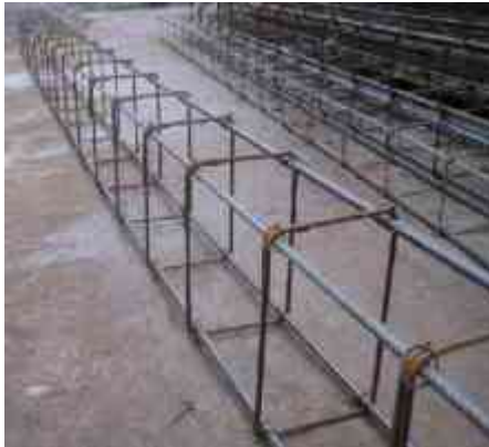
Imagen 109: Armado de trabe. Fuente: http://www.elconstituyente.mx/edgar-manuel-mendez-montoya-acero/ . [28 enero/2017]
