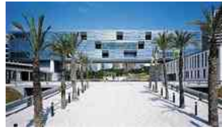
IMAGEN 11: fachada perspectiva del ayuntamiento. Fuente: http://www.via-arquitectura.net/12/12-038.htm [24/Sep/2015]
