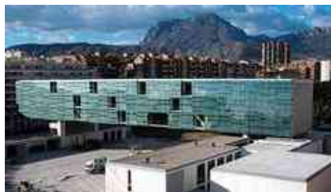
IMAGEN 7: Fachada principal del ayuntamiento Fuente: http://www.via-arquitectura.net/12/12-038.htm [23/Sep/2015]
