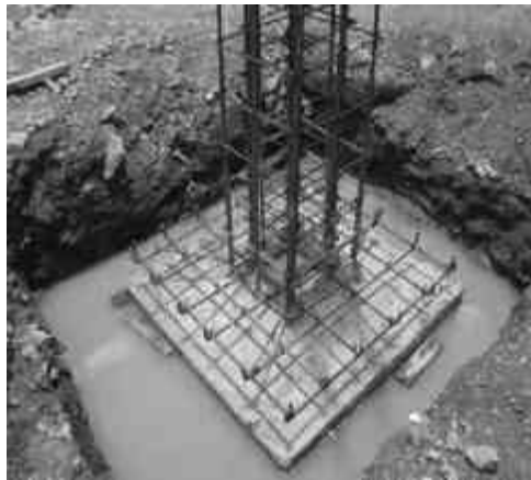
Imagen 107: vista de armado de columna. Fuente: http://www.thehouseofblogs.com/articulo/894824.html . [28 enero/2017]
