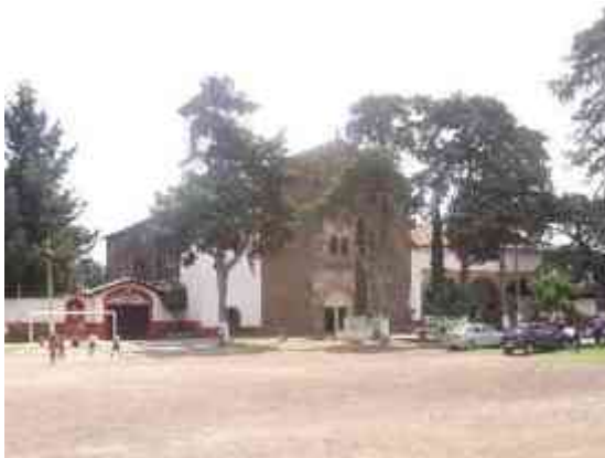
Imagen 70: fachada principal de la iglesia de la virgen de la asunción de Erongarícuaro. Fuente: Benjamín Cortes Sebastián [3/Oct/2015]
