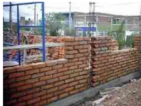
Imagen 112: Muro de ladrillo colocado en sitio. Fuente: https://www.google.com.mx/search?q=muro+de+tabique+rojo+recocido&espv=2&biw=1366&bih=662&source=lnms&tbm=isch&sa=X&ved=0ahUKewjrvvXr7zSAhUX24MKHZhWAOwQ_AUIBigB#tbn=isch&q=muro+de+tabique&*imgsrc=LzfhxhzVerqpnM:.. [28 enero/2017]
