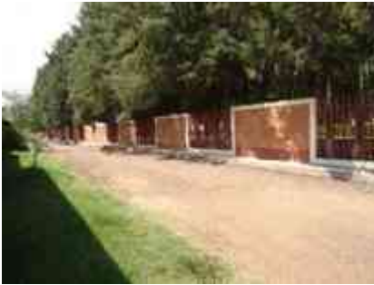
Imagen 43: Fachada Lateral de la secundaria federal Heroína María Luisa Martínez. Foto tomada por Benjamín Cortes Sebastián [30/ Sep/2015]
