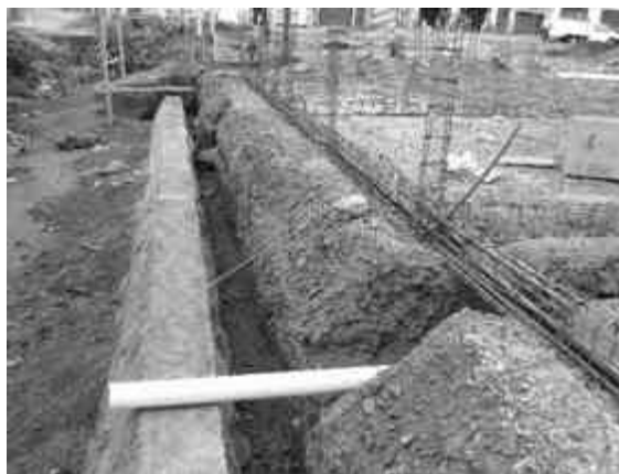
Imagen 74. Colocación de conexión a colector. (Foto tomada por Karim Alan Corona Hernández).
