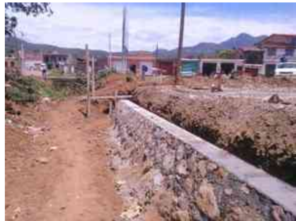
Imagen 38. Muro de contención en colindancia con el canal (Foto tomada por Karim Alan Corona Hernández).
