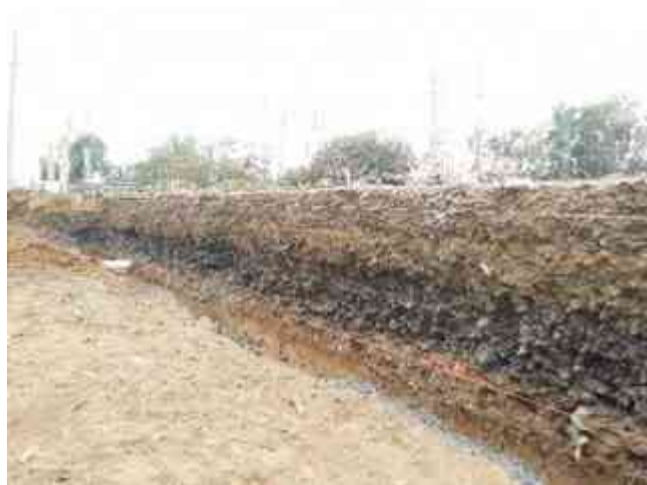
Imagen 15. Corte de la plataforma para desplante de muro de contención. (Foto por Karim Alan Corona Hernández)
