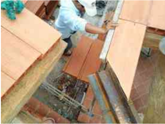
Imagen 67. Colocación de la viga IPR, vigas de madera y novalosa sobre viga IPR. (Foto tomada por Arq. Antonio Ruíz Lagunas).
