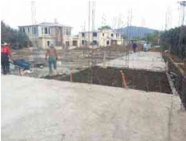
Imagen 28. Previo al curado de las losas de cimentación. (Foto por Karim Alan Corona Hernández)
