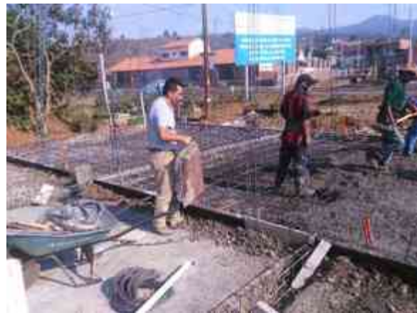
Imagen 26. Proceso de colado y extracción de muestras para resistencia de concreto. (Foto por Karim Alan Corona Hernández)
