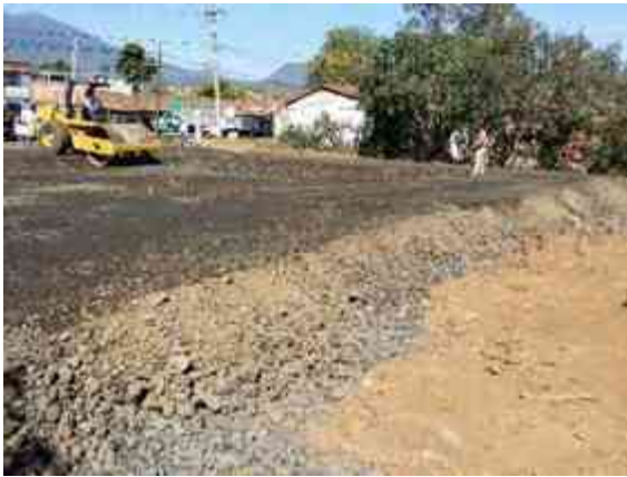
Imagen 17. Compactación de la capa de base hidráulica. (Foto por Karim Alan Corona Hernández)
