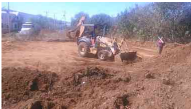
Imagen 10. Despalme del terreno previo a la apertura de caja. (Foto por Karim Alan Corona Hernández).
