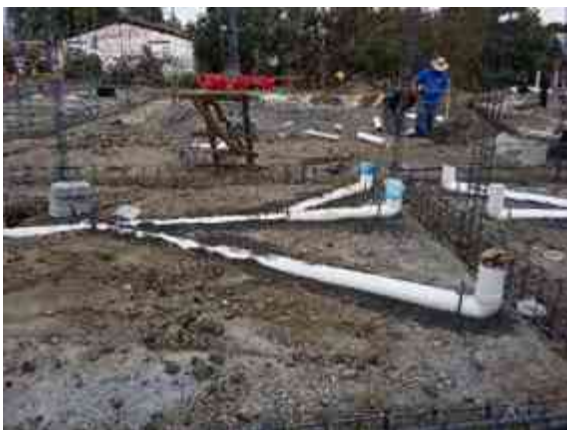
Imagen 75. Colocación de salidas sanitarias. (Foto tomada por Karim Alan Corona Hernández).
