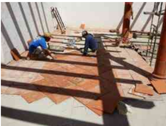
Imagen 83. Colocación de piso en pasillos y cubo de escaleras. (Foto tomada por Karim Alan Corona Hernández).
