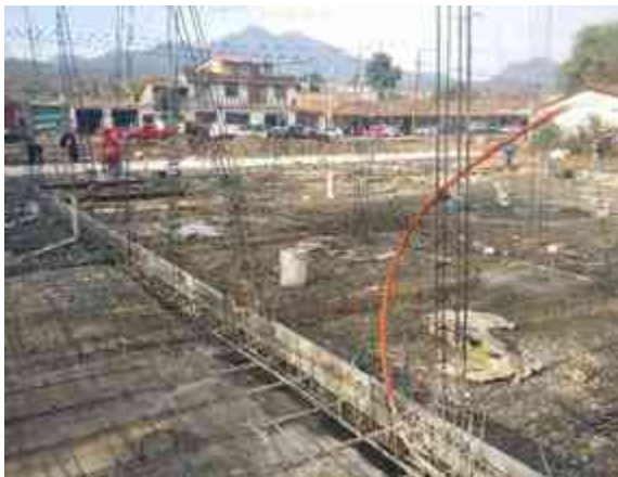
Imagen 33. Armado de contra trabes. (Foto tomada por Karim Alan Corona Hernández).
