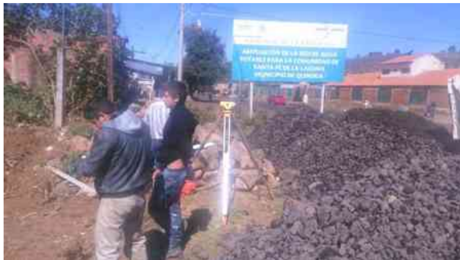
Imagen 6. Cuadrilla de Topografía con nivel automático para el trazo de plataforma. (Tomada por Karim Alan Corona Hernández)
