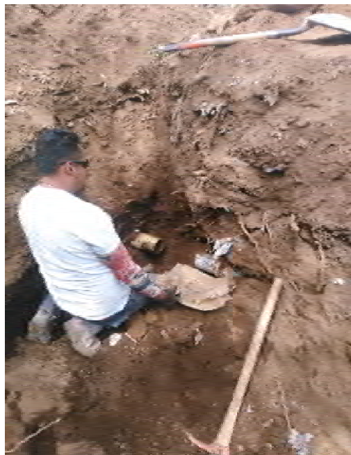
Imagen 12. Reparación de la tubería perforada. (Foto por Karim Alan Corona Hernández).
