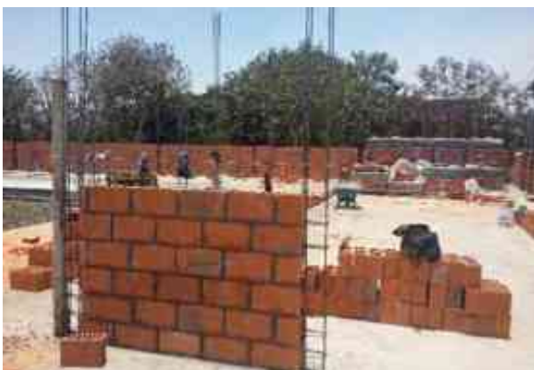
Imagen 57. Elaboración de muros de tabique extruido. (Foto tomada por Karim Alan Corona Hernández).
