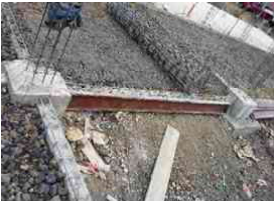
Imagen 19. Colado de contra trabes en cimentación y dados colados. (Foto por Karim Alan Corona Hernández)
