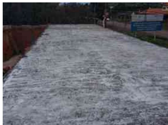
Imagen 54. Aplicación de la membrana de curado. (Foto tomada por Karim Alan Corona Hernández).
