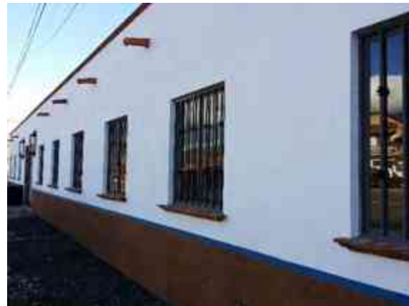
Imagen 93. Vista de Ventanas de Herrería. (Foto tomada por Arq. Antonio Ruíz Lagunas).
