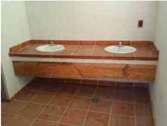
Imagen 87. Terminado de los muebles sanitarios. (Foto tomada por Karim Alan Corona Hernández).
