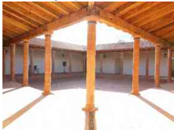
Imagen 96. Vista del Inmueble antes de la inauguración. (Foto tomada por Arq. Antonio Ruíz Lagunas).
