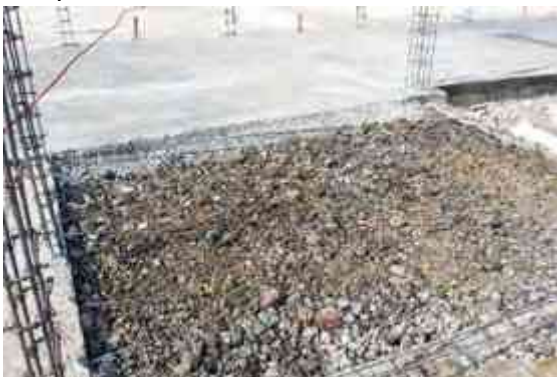
Imagen 59. Armado de la malla electrosoldada y colado del firme. (Foto tomada por Karim Alan Corona Hernández).
