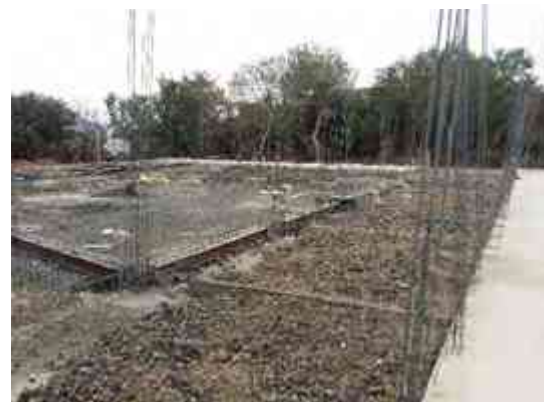
Imagen 35. Colado de las contra trabes. (Foto tomada por Karim Alan Corona Hernández).
