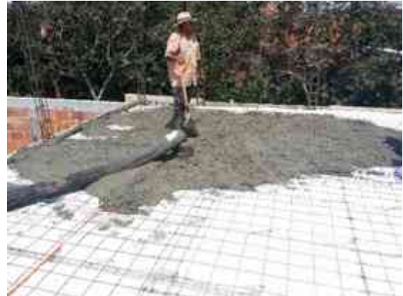
Imagen 51. Colado de losa sobre oficinas con concreto bombeado premezclado. (Foto tomada por Arq. Antonio Ruíz Lagunas).
