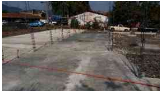
Imagen 58. Piso de concreto ya colado. (Foto tomada por Karim Alan Corona Hernández).
