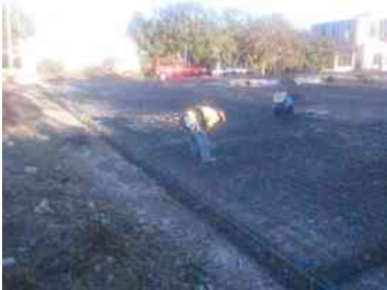
Imagen 27. Armado de la losa de cimentación. (Foto por Karim Alan Corona Hernández).
