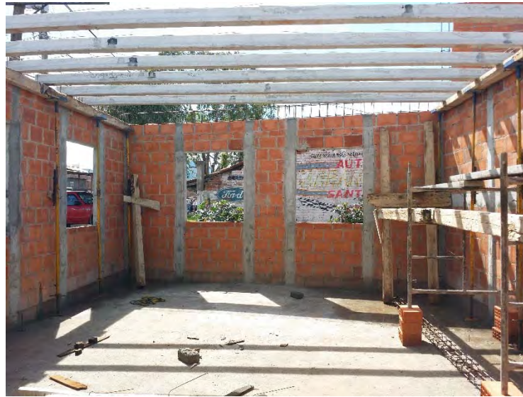
Imagen 48. Elevación de viguetas a vigas madrinas. (Foto tomada por Karim Alan Corona Hernández).
