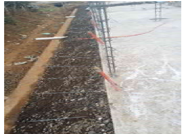
Imagen 31. Curado de las losas de cimentación. (Foto por Karim Alan Corona Hernández)
