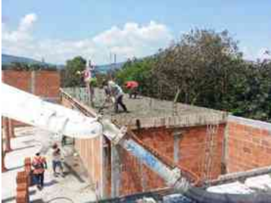
Imagen 52. Colado de losa sobre sanitarios (Foto tomada por Arq. Antonio Ruíz Lagunas).
