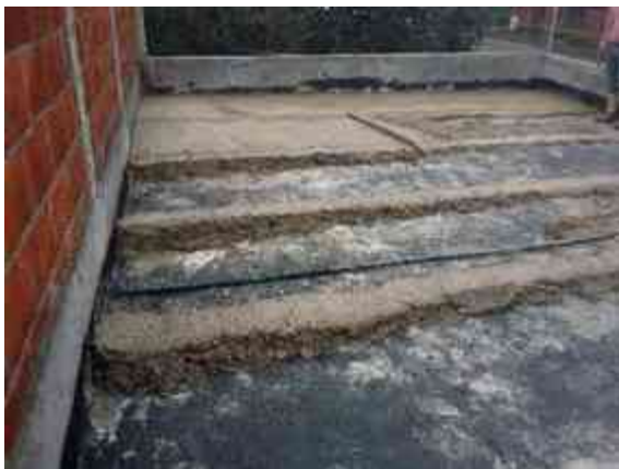
Imagen 85. Proceso de entortado para dar pendientes. (Foto tomada por Arq. Antonio Ruíz Lagunas).
