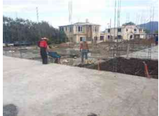
Imagen 29. Previo al curado de las losas de cimentación. (Foto por Karim Alan Corona Hernández)
