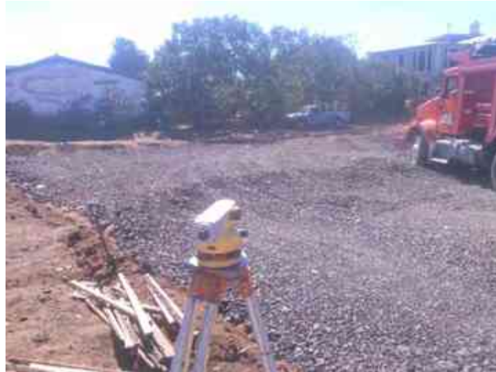
Imagen 7. Tendido de capa de estabilización (filtro). (Tomada por Karim Alan Corona Hernández)
