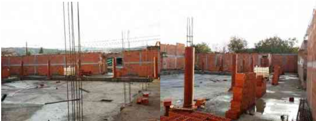
Imagen 42. Armado de columnas y columnas ya plomeadas listas para colado. (Foto por Karim Alan Corona Hernández)
