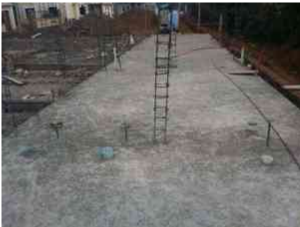
Imagen 30. Curado de las losas de cimentación. (Foto por Karim Alan Corona Hernández)
