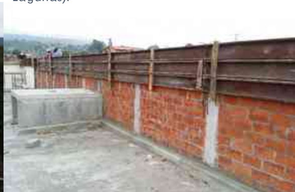
Imagen 86. Terminado de la azotea con la lechereada y vista final. (Foto tomada por Arq. Antonio Ruíz Lagunas).
