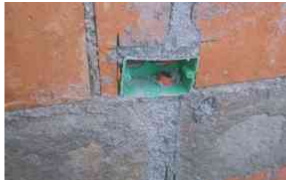
Imagen 78. Salida eléctrica antes de cableado. (Foto tomada por Luis Fernando Lara Núñez).
