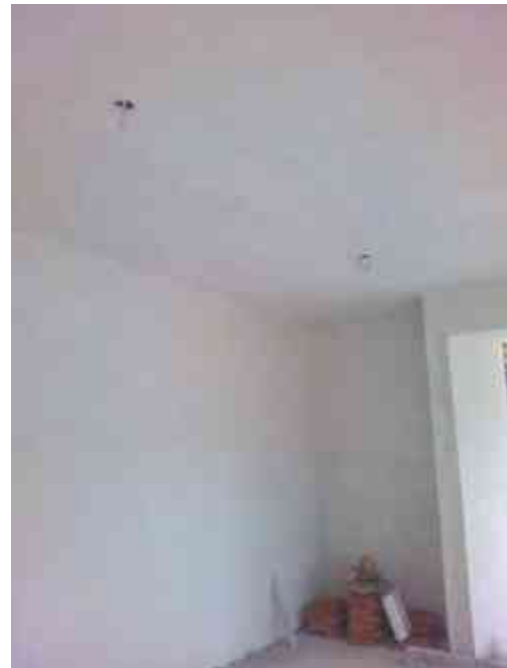
Imagen 80. Afinado ya terminado de mortero stucco. (Foto tomada por Luis Fernando Lara Núñez).
