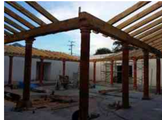
Imagen 65. Vista de colocación de vigas. (Foto tomada por Arq. Antonio Ruíz Lagunas).
