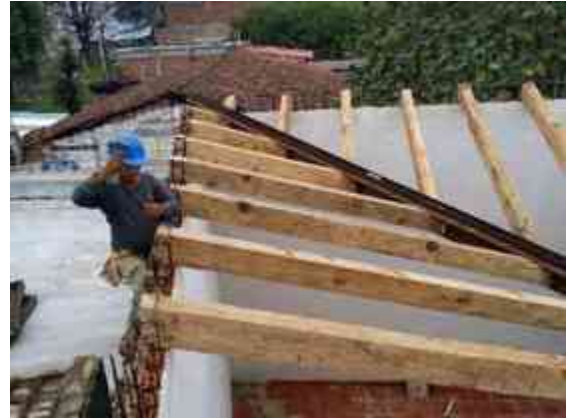
Imagen 68. Anclado de Vigas en Trabe de Cerramiento. (Foto tomada por Arq. Antonio Ruíz Lagunas).
