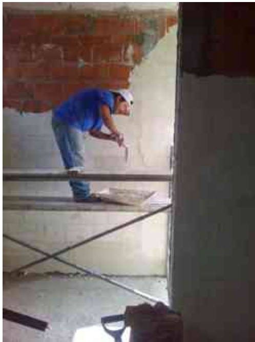
Imagen 81. Aplicación de repellado con el mortero stucco. (Foto tomada por Luis Fernando Lara Núñez).
