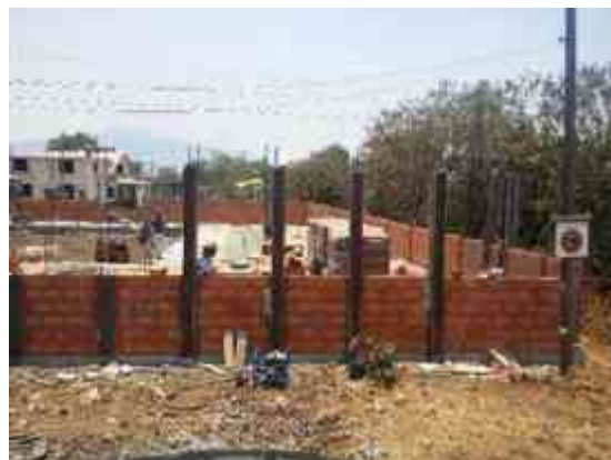
Imagen 56. Elaboración de muros de tabique extruido. (Foto tomada por Karim Alan Corona Hernández).
