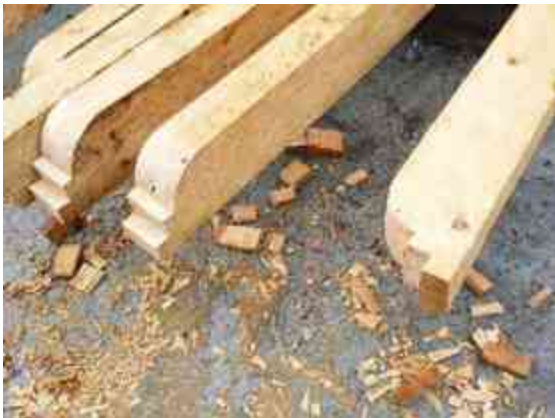
Imagen 66. Formado de pechos de paloma en vigas y colocación de las mismas. (Foto tomada por Arq. Antonio Ruíz Lagunas).
