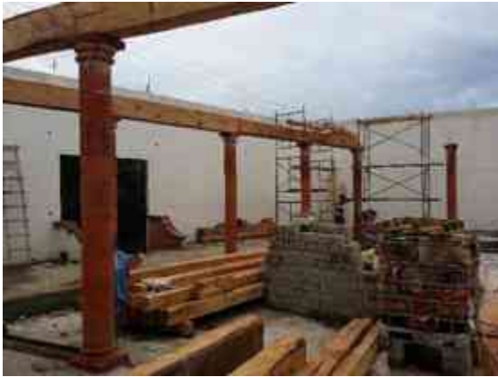
Imagen 64. Colocación de las gualdras de madera de pino de primera. (Foto tomada por Arq. Antonio Ruíz Lagunas).
