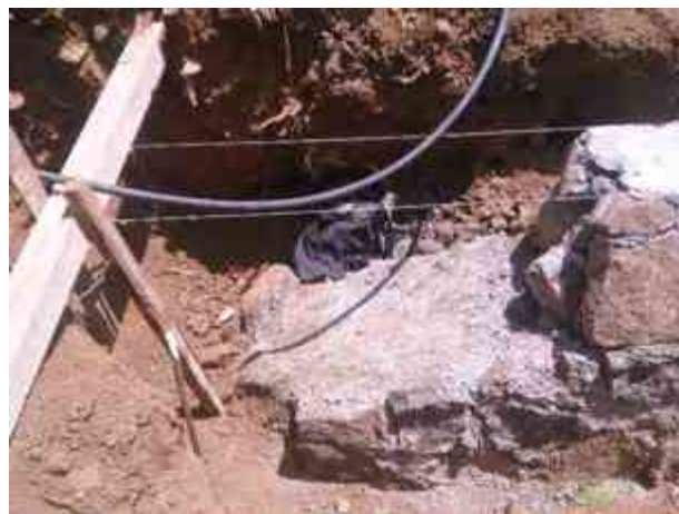
Imagen 40. Construcción de muro de contención. (Foto tomada por Karim Alan Corona Hernández).
