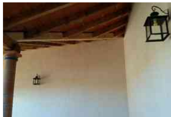
Imagen 90. Vista de las Farolas en pasillos con luminarios LED. (Foto tomada por Karim Alan Corona Hernández).
