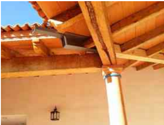
Imagen 94. Vista de Refuerzo de Vigas de Acero con remate en forma de gárgola. (Foto tomada por Karim Alan Corona Hernández).
