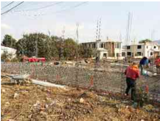
Imagen 45. Armado de castillos. (Foto tomada por Karim Alan Corona Hernández).
