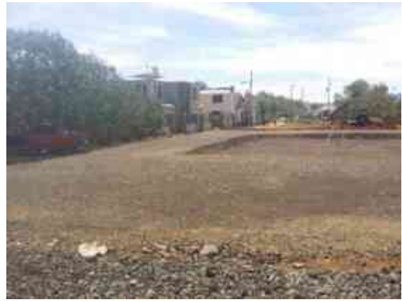
Imagen 16. Base hidráulica ya compactada y trazo de ejes de referencia. (Foto por Karim Alan Corona Hernández)
