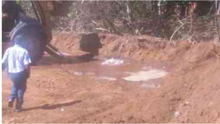
Imagen 11. Perforación de tubería durante el proceso de la apertura de caja. (Foto por Karim Alan Corona Hernández)
