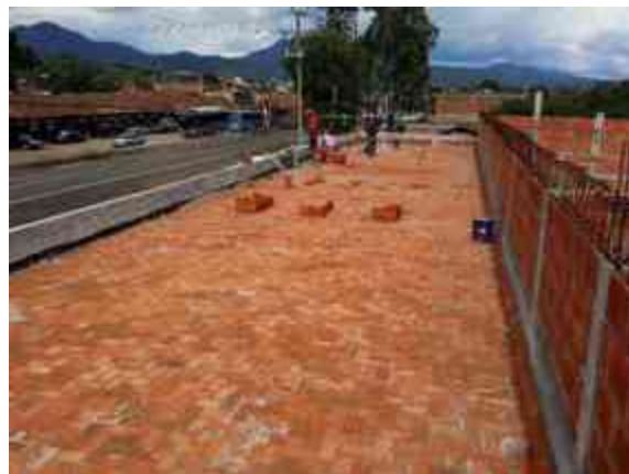
Imagen 84. Colocación de ladrillo en forma de petatillo. (Foto tomada por Arq. Antonio Ruíz Lagunas).
