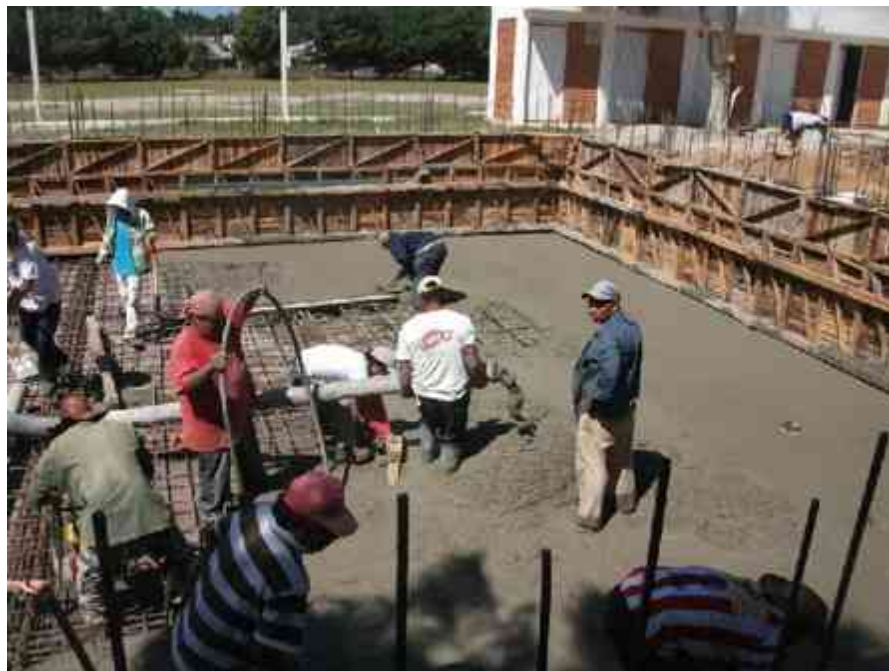
Inicio de colado de losa de cimentación en alberca
