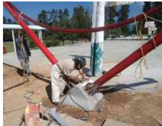
Colocación de refuerzos en columnas y anclaje de columnas en placa con cartabones de refuerzo
