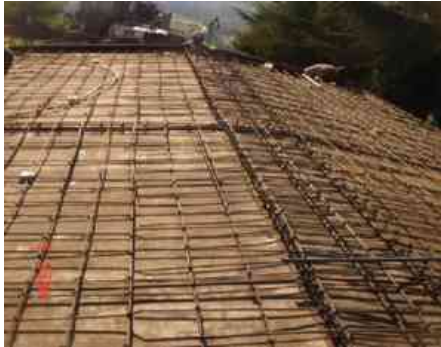
Armado de losa y trabe en módulo PREP
