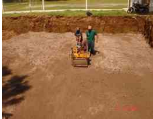
Suministro y colocación de material base compactada en capas de 20 cm.
