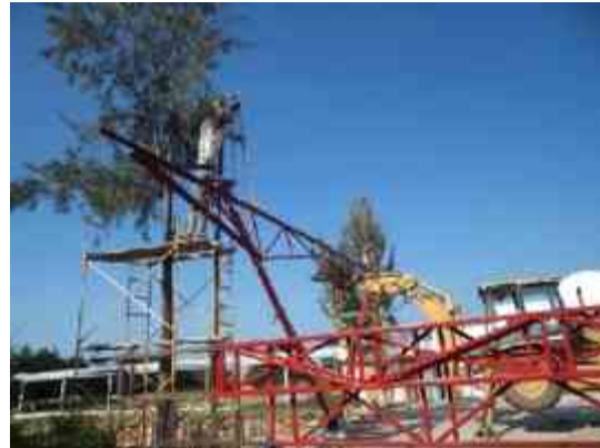
Armaduras a base de ángulo de 2"x1/8 y PTR en 2"
