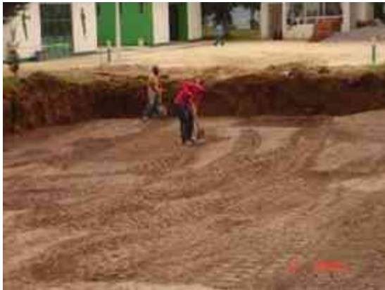
Afine y terminado de nivelación de base recibir losa de cimentación de alberca
