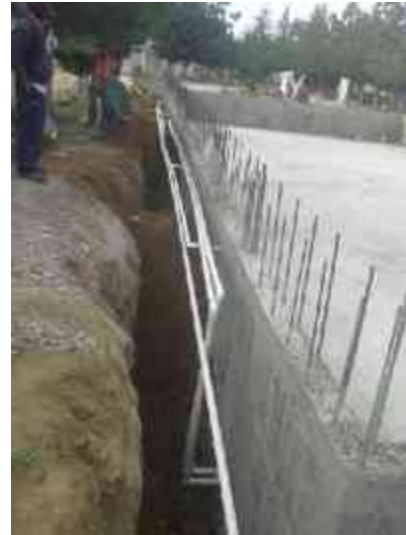
Suministro y colocación de tubería de PVC hidráulico RD-26, para instalación Hidráulica para mantenimiento de alberca
