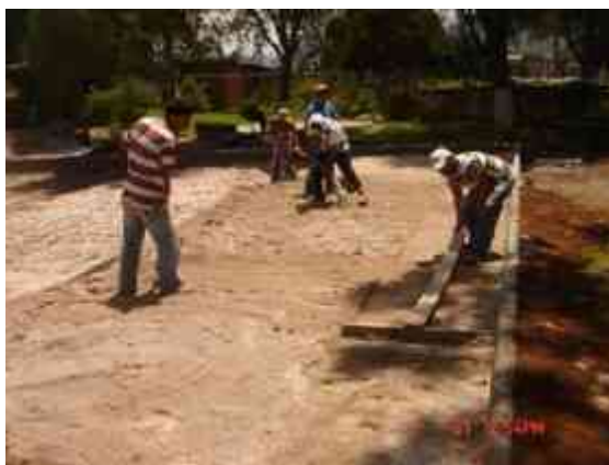
Suministro y colocación de arena cernida
