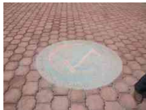
Adocreto y logo institucional forjado en concreto
