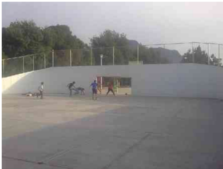
Colocación de Malla ciclónica calibre 10.5
