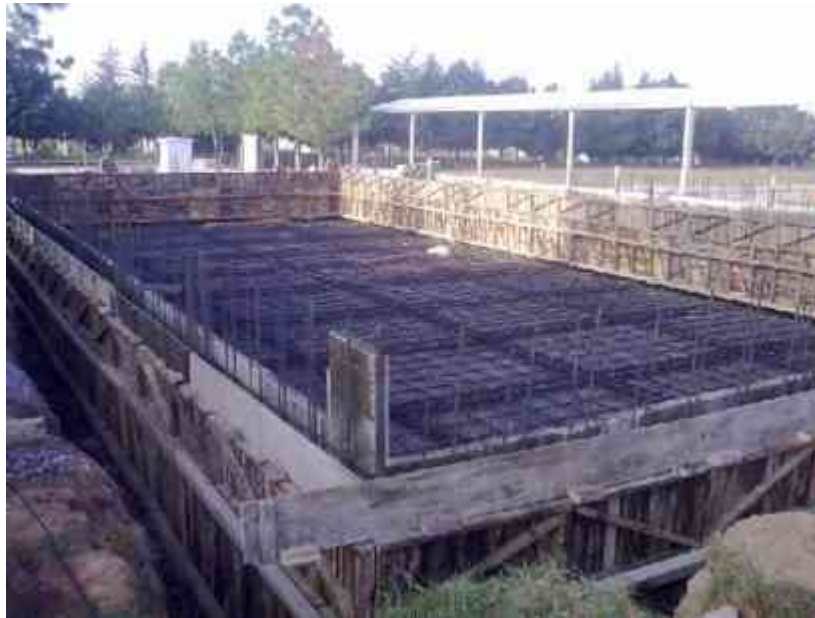
Cimbra a base de tarima en muros de alberca
