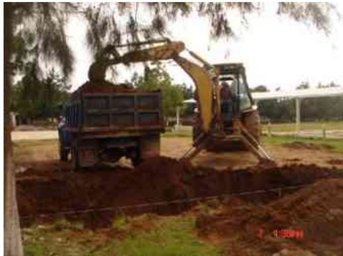
Excavación en área de fosa para alberca
