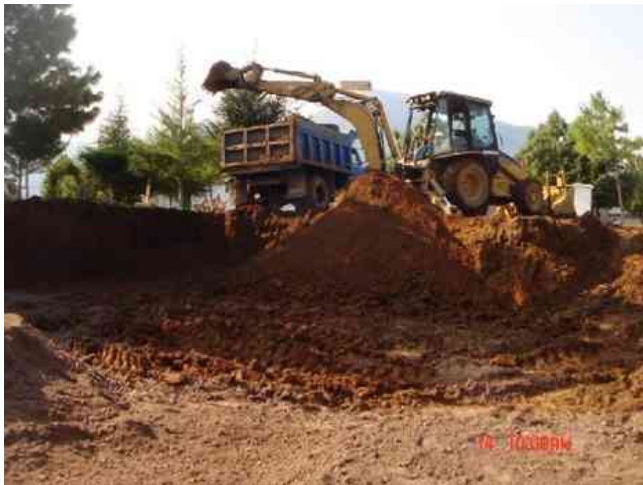
Excavación y retiro de material producto de excavación
