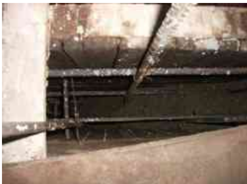
Vaciado de concreto en muros
