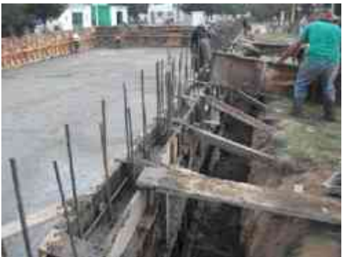
Suministro, colocación y vibrado de concreto premezclado en muros con f'c=250 kg/cm
