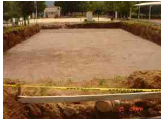
Afine y terminado de nivelación de base recibir losa de cimentación de alberca
