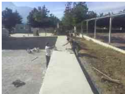
Colocación de acabado con pasta crestuco color blanco
