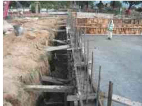
Suministro, colocación y vibrado de concreto premezclado en losa de cimentación con f'c=250 kg/cm, colocado a nivel y regla acabado fino con llana de madera
