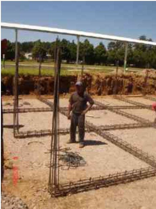
Armando de trabes y columnas con acero del no. 3, no. 4, no. 5.
