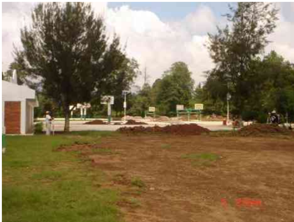
Nivelación de terreno por medios digitales
