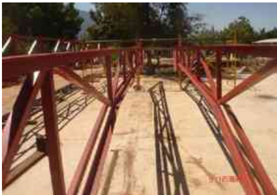
Armaduras a base de ángulo de 2"x1/8 y PTR en 2"
