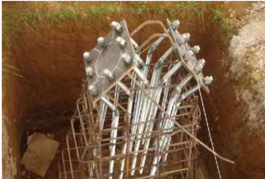
Colocación de anclas y placa metálica la cual se colocó a nivel para recibir columnas de acero
