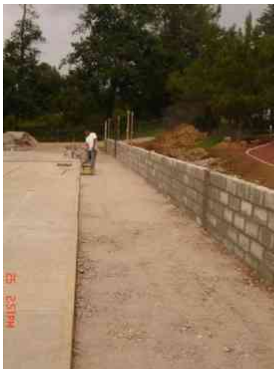
Elaboración de muro y colado de castillos en muros laterales
