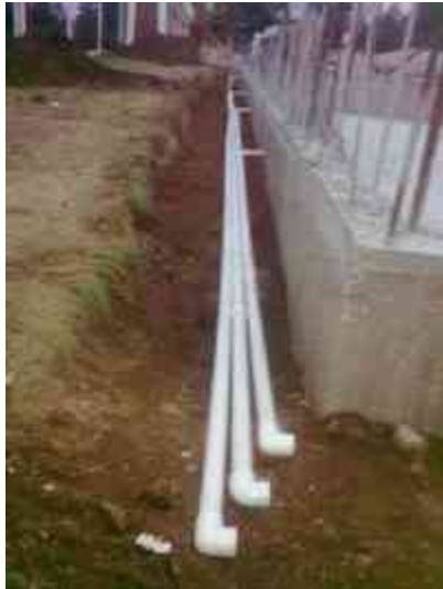
Suministro y colocación de tubería de PVC hidráulico RD-26, para instalación Hidráulica para mantenimiento de alberca
