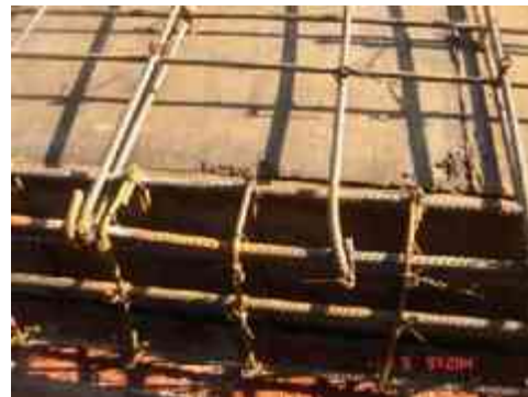
Cadena de cerramiento y amarre de losa
