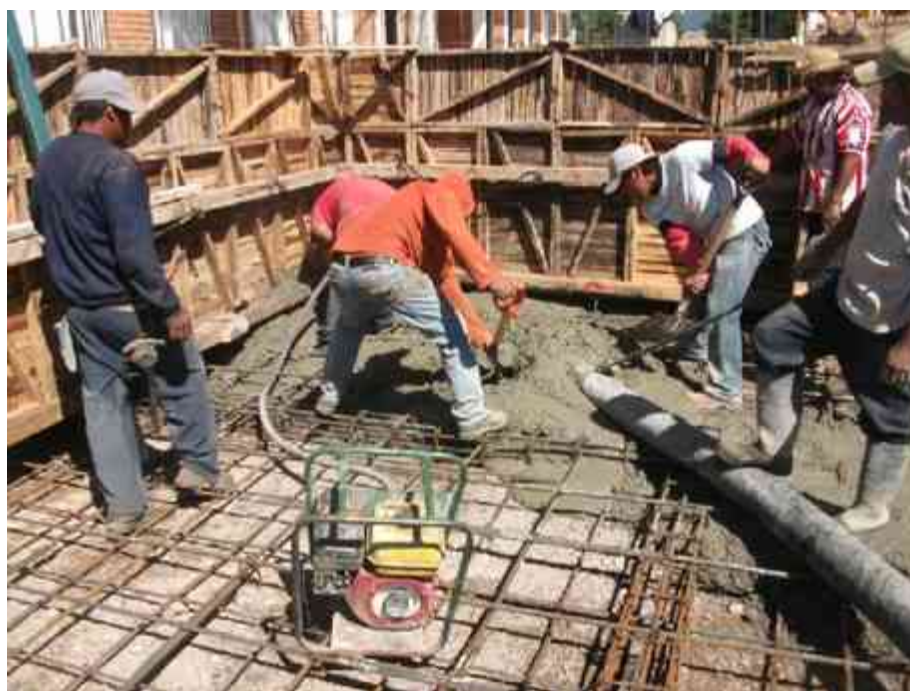
Tendido y vibrado de concreto
