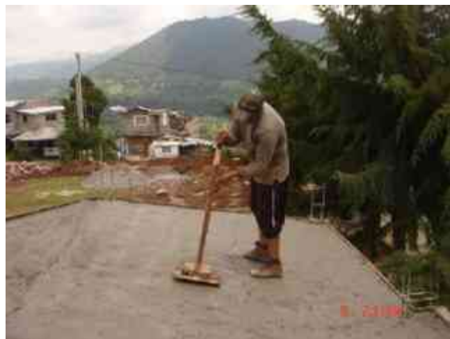
Compactación de concreto en losa
