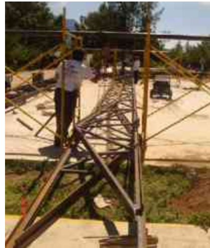
Armado de columnas y capiteles contuvo de fofu cedula 40 en 6" de diámetro
