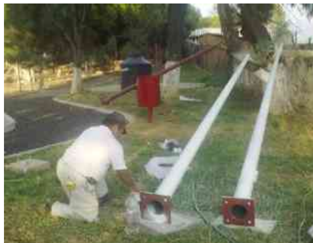
Colocación de pintura de esmalte a dos manos en postes para luminarias
