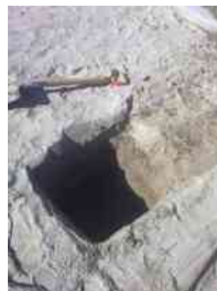
excavación para dados de concreto
