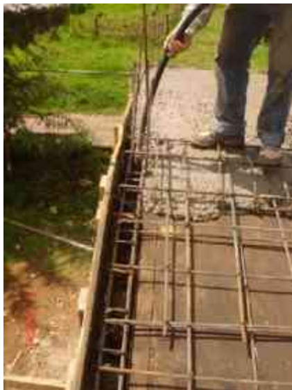
Vibrado de concreto
