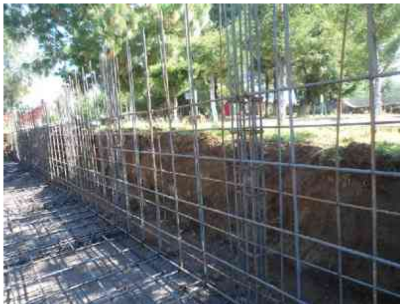
Acero de refuerzo del no. 3 y 4, con separador de emparrillado a base de acero del no. 3 en muro.
