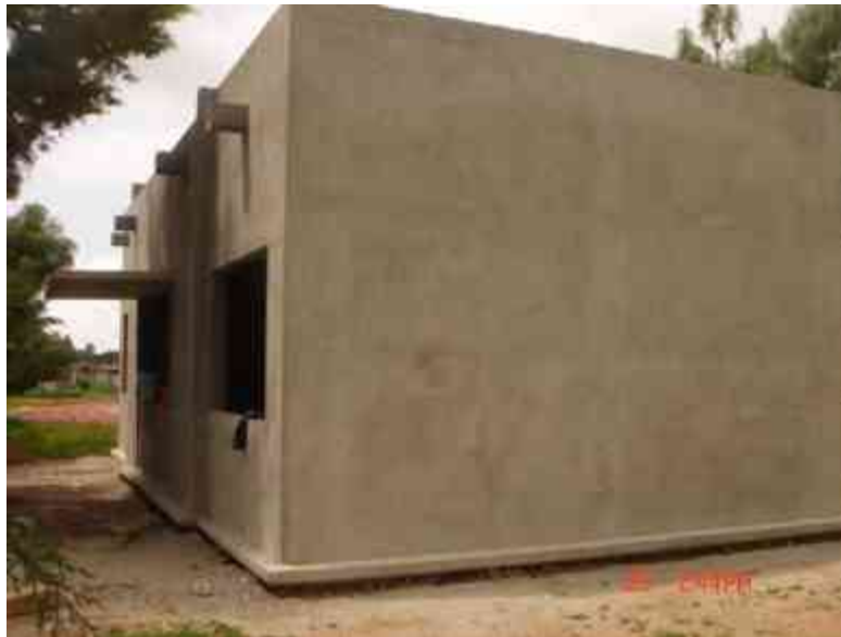
APLANADO ACABADO FINO EXTERIORES
