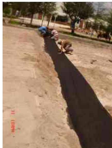
colocación de tela anti hierba
