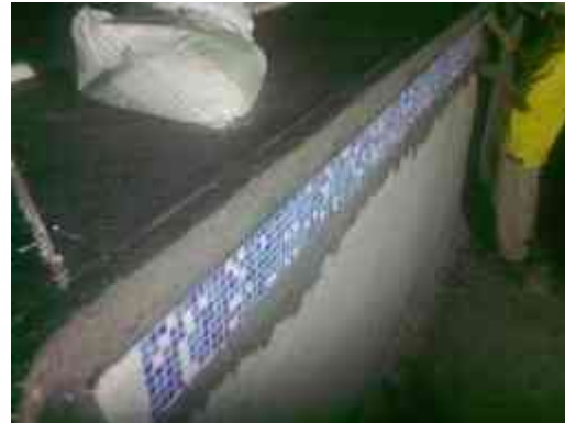
Colocación de cenefa a base de azulejo tipo veneciano
