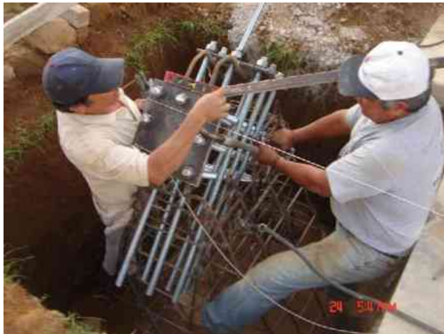
Colocación de anclas y placa metálica la cual se colocó a nivel para recibir columnas de acero
