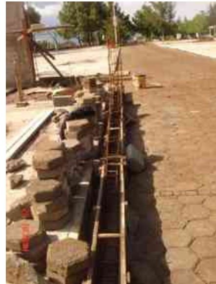
Suministro y colocación de armex 10x15 en cadena
