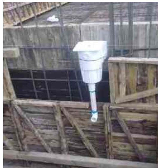
Colocación de Desnatador
