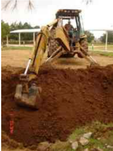
Excavación en área de fosa para alberca
