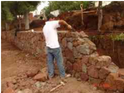
Elaboración de muro de contención a base de piedra
