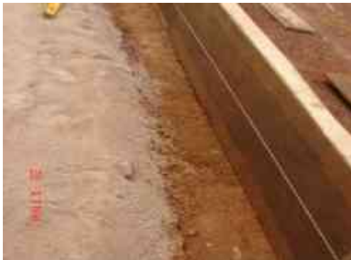
Relleno con material de banco compactado
