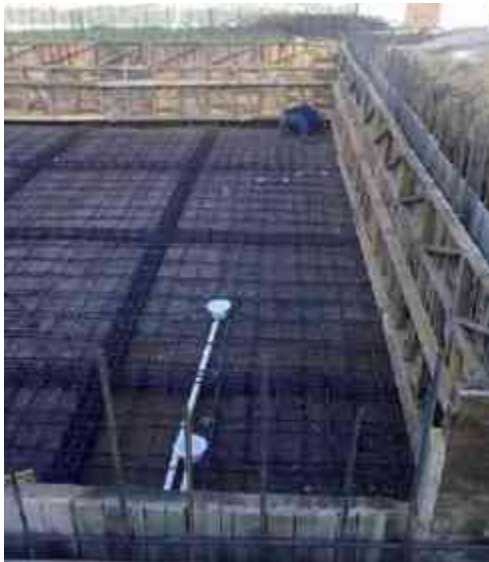
Colocación de Desarenador de fondo
