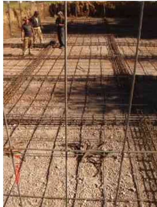
Armando de emparrillado con acero de refuerzo del no. 4.
