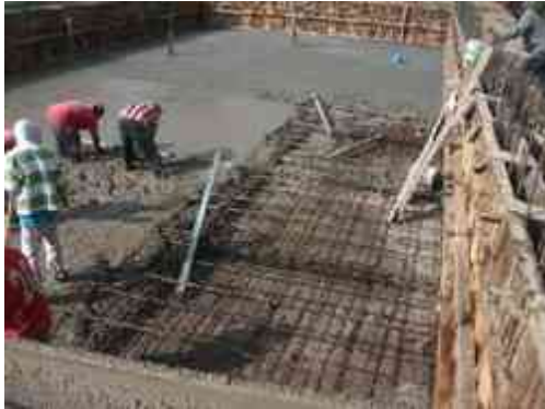
Suministro, colocación y vibrado de concreto premezclado en losa de cimentación con f'c=250 kg/cm, colocado a nivel y regla acabado fino con llana de madera
