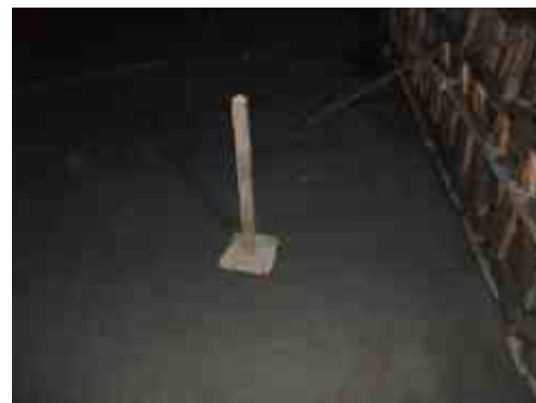
apisonado en losa de cimentación
