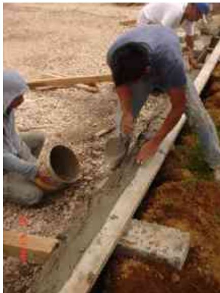
Construcción de Guarnición
