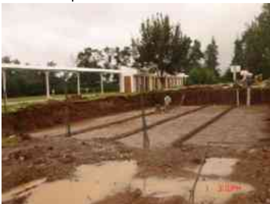
Habilitado y armado de trabes en losa de cimentación y muros
