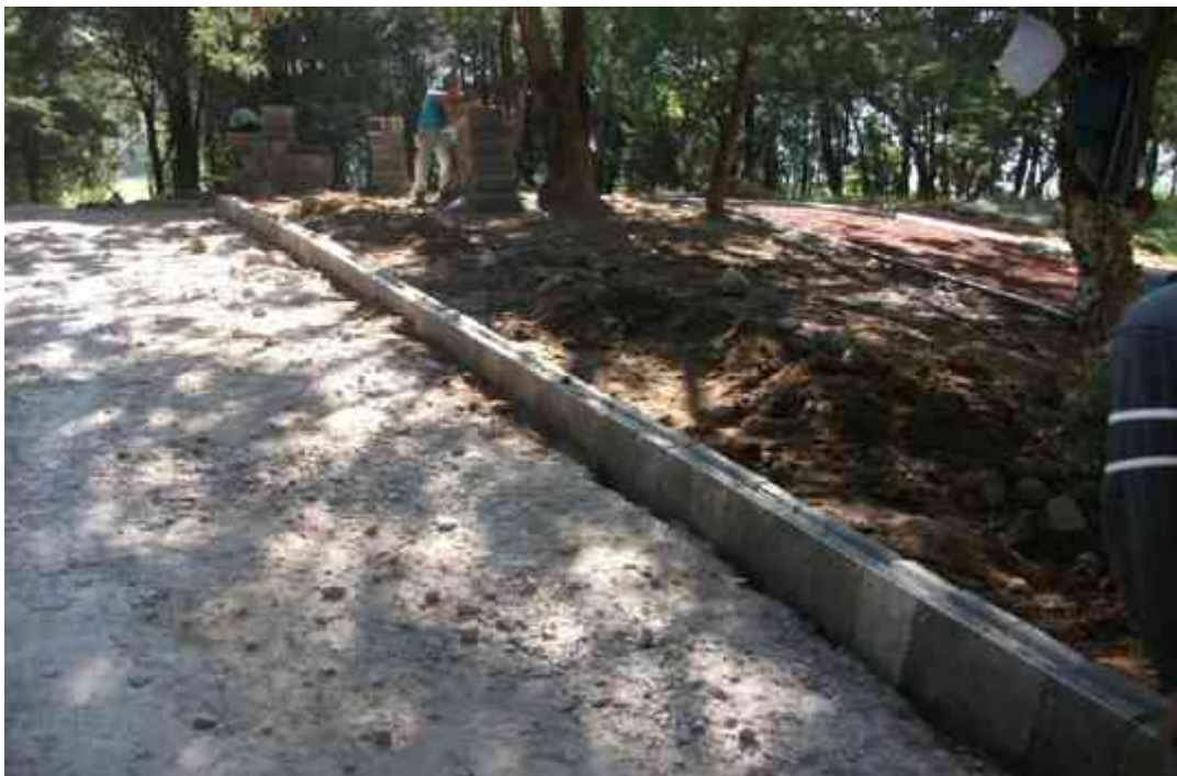
Conformación de base y guarnición en accesos de servicio
