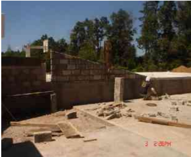
Elaboración de muro de Block y colado de castillos
