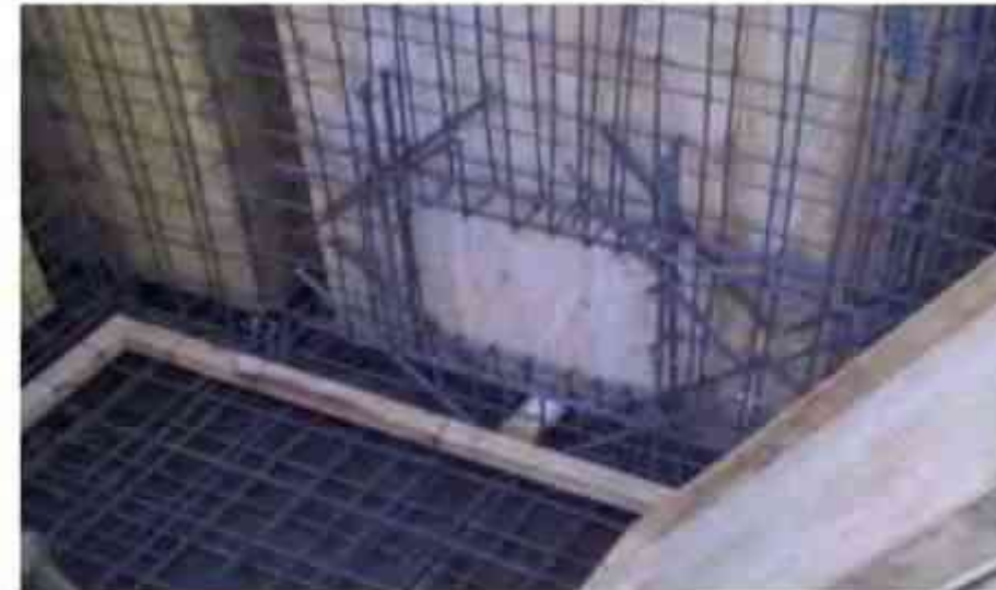
Foto 4 de 4 Estado de avance. Esta foto fue tomada en el cruce de los ejes 2 y B3, en esta se puede ver el armado de los pasos hombre en las celdas del cajón de la cimentación. Fecha: 21.12.2010
