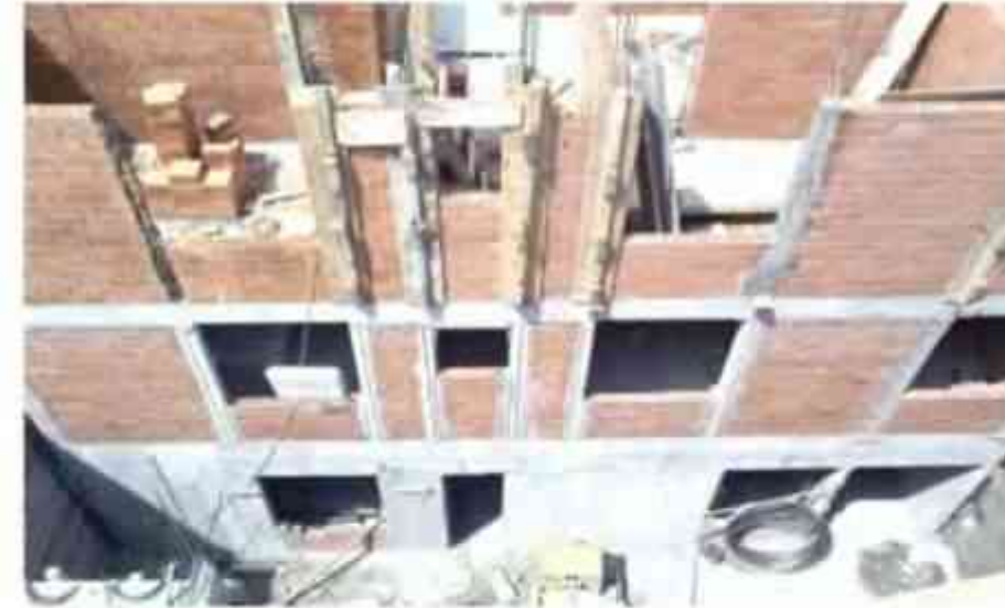
Foto 7 de 11 Estado de avance
