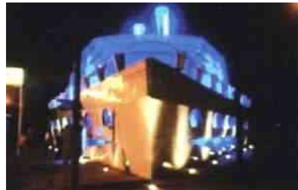
Fachada actual con iluminación nocturna
