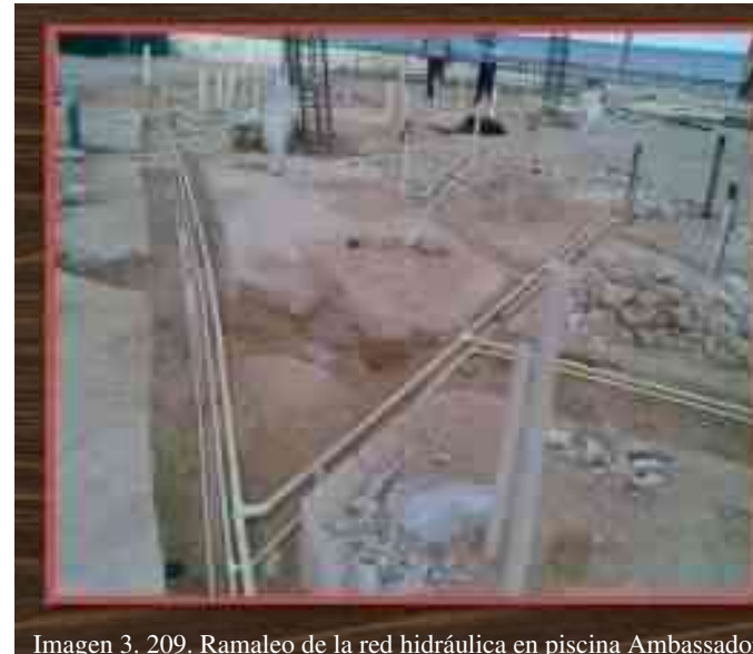
Imagen 3. 209. Ramaleo de la red hidráulica en piscina Ambassador.
