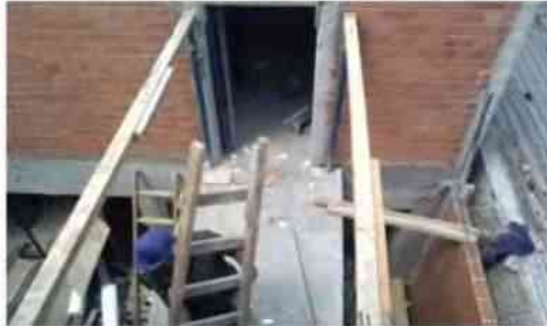
Foto 4 de 11 Estado de avance
