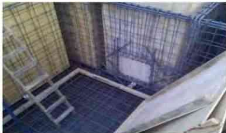
Foto 3 de 4 Estado de avance. Esta foto fue tomada en el cruce de los ejes 2 y B3, en esta se puede ver el armado de los pasos hombre en las celdas del cajón de la cimentación. Fecha: 21.12.2010
