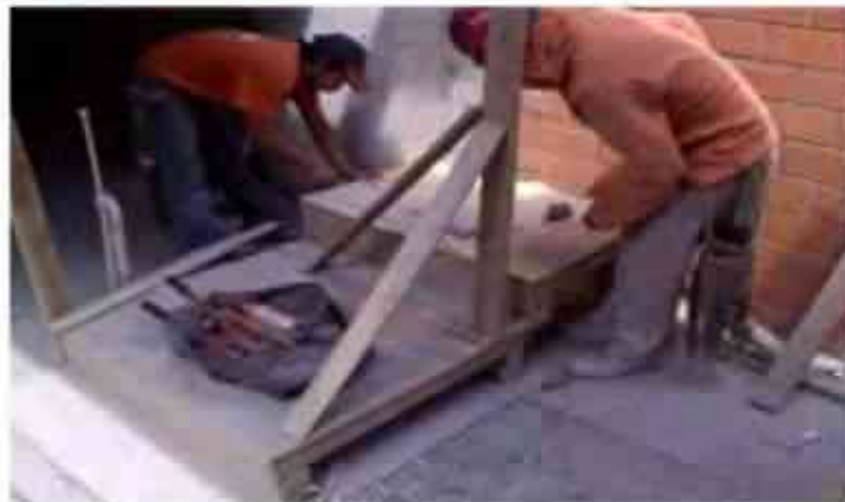
Foto 6 de 11 Estado de avance
