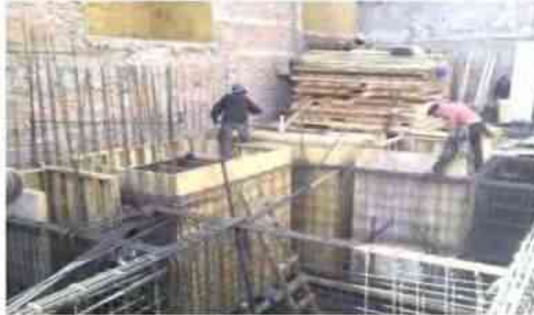
Foto 1 de 4 Estado de avance. En esta foto fue tomada desde el punto del eje 2, con vista al muro colindante izquierdo, se puede ver la colocación de cimbras en la contratrabes ubicadas en los muros de colindancia, así como las intermedias. Fecha: 21.12.2010
