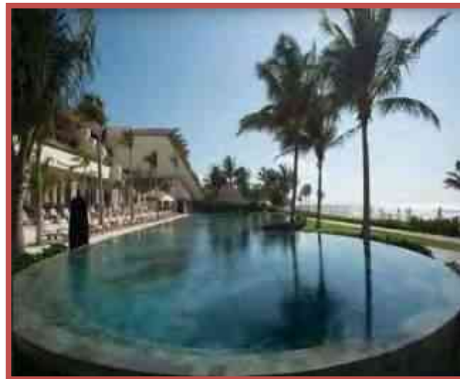
Imagen 3. 120. Rebosadero Piscina Gran Class. (*)
