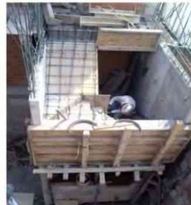
Foto 8 de 11 Estado de avance
