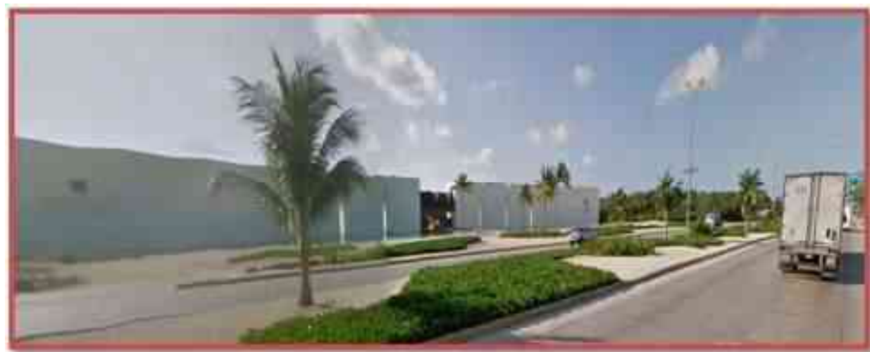
Imagen 3. 4.Fachada del ‘HOTEL GRAND VELAS, ALL SUITES SPA & RESORT’, también se puede apreciar el tipo de decoración que se puede apreciar en el trayecto de esta carretera.
