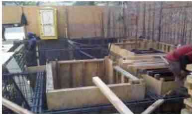
Foto 2 de 4 Estado de avance. Esta foto se tomó en la parte central de la escalera, con vista al frente del predio, esta es el área del 50% de la caja de la cimentación que se pretende colar para el día jueves de la semana en curso. Fecha: 21.12.2010
