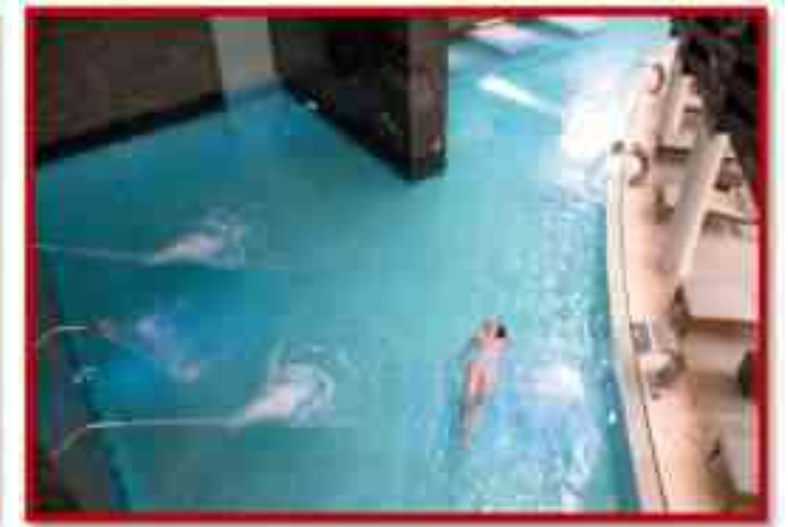
Imagen 3. 66. Aspersores de agua en piscina de alta presión. (*)
