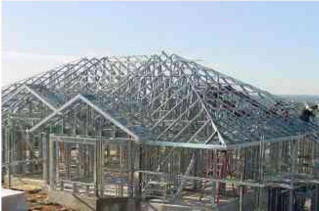
Fig. 23: Construcción con Estructura de Acero.
