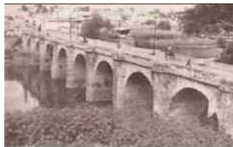
Fig. 2: Puente Cabadas, construido entre 1832 y 1833
