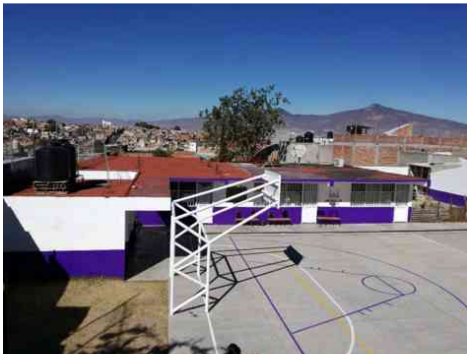
Fig. 22. Escuela de Artes y Oficios en la colonia Independencia, Morelia. Se aprecian los salones de clases, un extremo de la cancha de basquetbol y el módulo de baños con el tinaco en su parte superior. Fuente: FJVJ.
