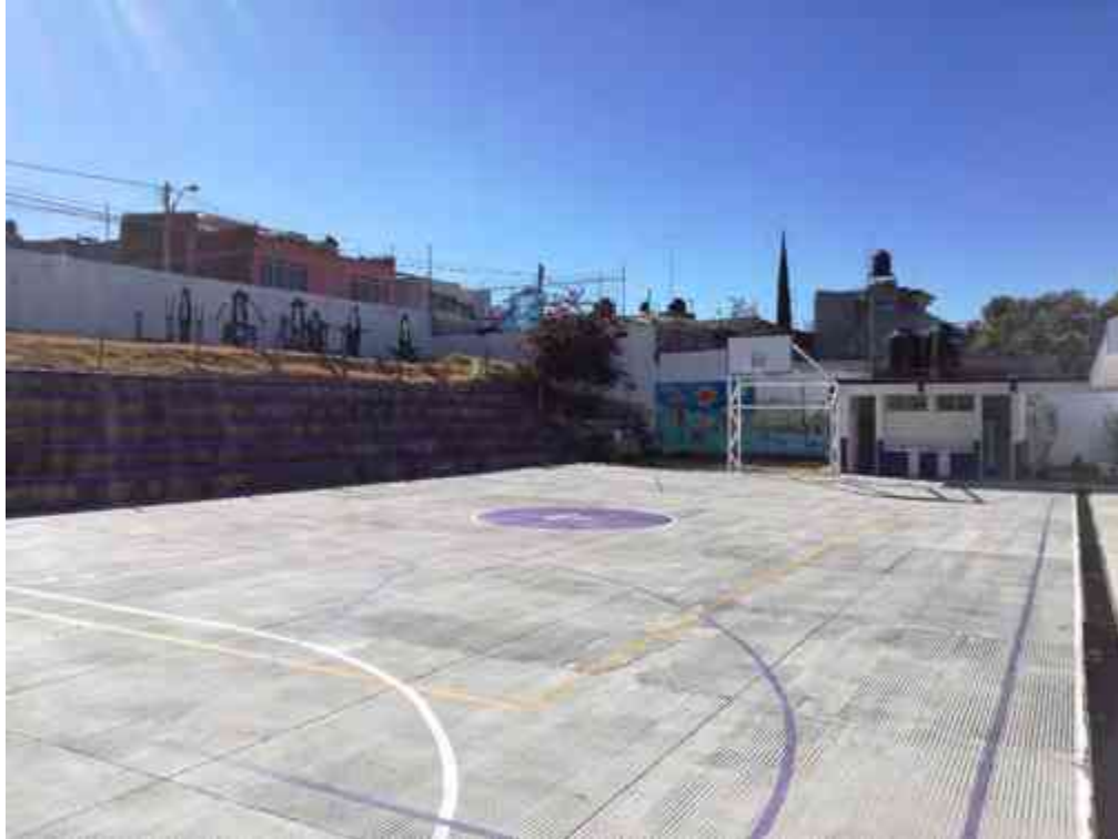
Fig. 23. Escuela de Artes y Oficios en la colonia Independencia, Morelia. Foto tomada desde el acceso de la calle, la cual muestra las gradas que ven hacia la cancha, así como el área destinada para aparatos de gimnasio, al fondo. Fuente: FJVJ.
