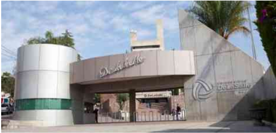
Figura 20. Residencia De La Salle Bajío.
