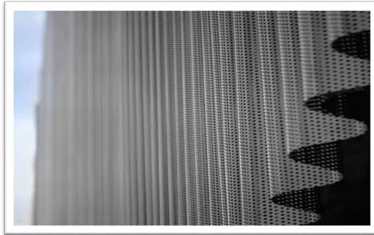
Figura 27. Placas de acero, forma final del panel.
