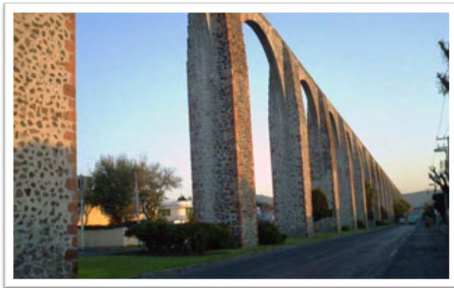
Figura 25. Acueducto, Ciudad de Querétaro.
