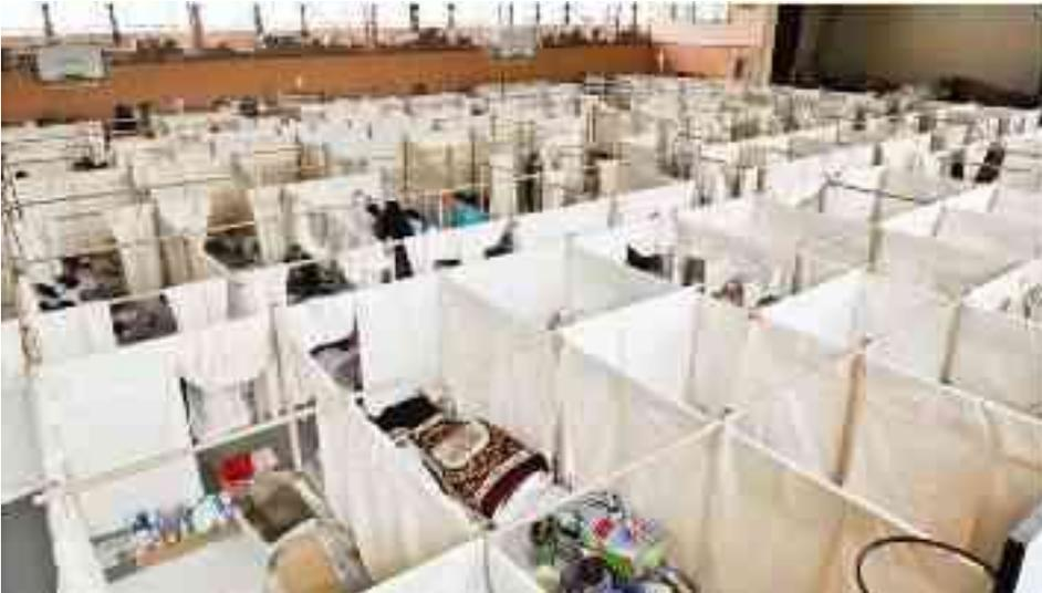
Ilustración 2 sistema de particiones interiores de papel en albergue para terremoto y tsunami2011.
