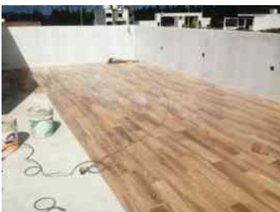
Img. 174 colocacion de piso cerámico apariencia madera en obra, fuente: Imagen propia del autor.
