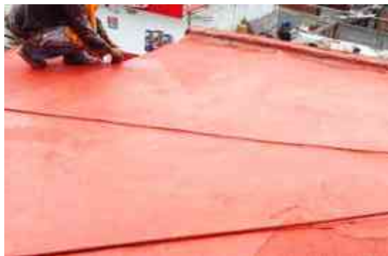
Img. 182 aplicación de impermeabilizante, fuente: Imagen propia del autor.
