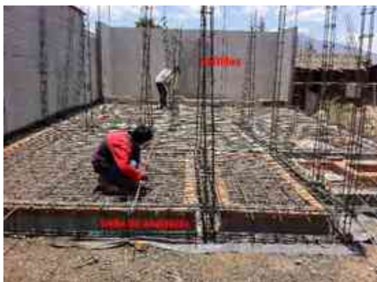
Img. 161 obra casa residencial, fuente: imagen propia del autor. Junio 2017
