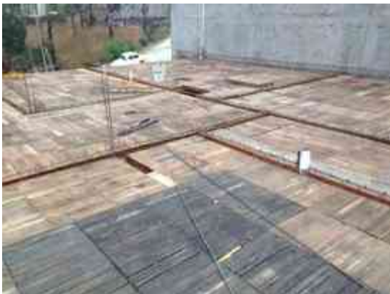
Img. 167 preparación de cimbra en obra, fuente: imagen propia del autor. Junio 2017.
