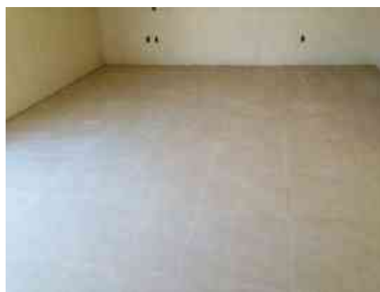
Img. 175 colocacion de piso cerámico en obra, fuente: Imagen propia del autor.
