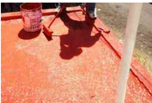
Img. 181 aplicación de impermeabilizante, fuente: Imagen propia del autor.
