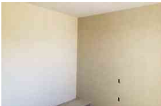
Img. 179 aplicación de pasta texturizada en muro, fuente: Imagen propia del autor.
