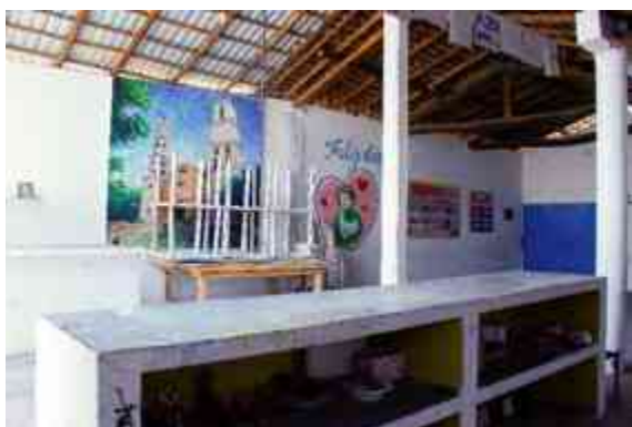
Img. 05. Instalaciones Casa de la Cultura Ajuchitlán, fuente: Imagen propia del autor, mayo 2017.
