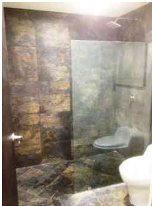
Img. 187 uso de cristal templado en baño, fuente: Imagen propia del autor.
