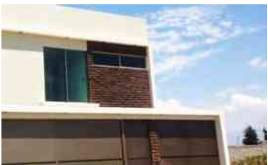
Img. 185 fachada con cantera, fuente: Imagen propia del autor.
