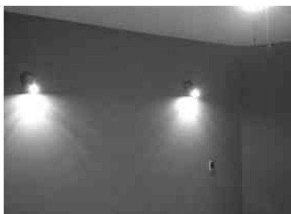
Img. 178 aplicación de pintura vinílica en muro, fuente: Imagen propia del autor.
