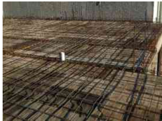
Img. 168 armado de losa maciza, fuente: imagen propia del autor. Junio 2017.
