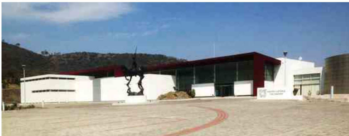
Img. 54 Centro Cultural y de Convenciones Tres Marías, fuente: imagen propia del autor, mayo 2017.
