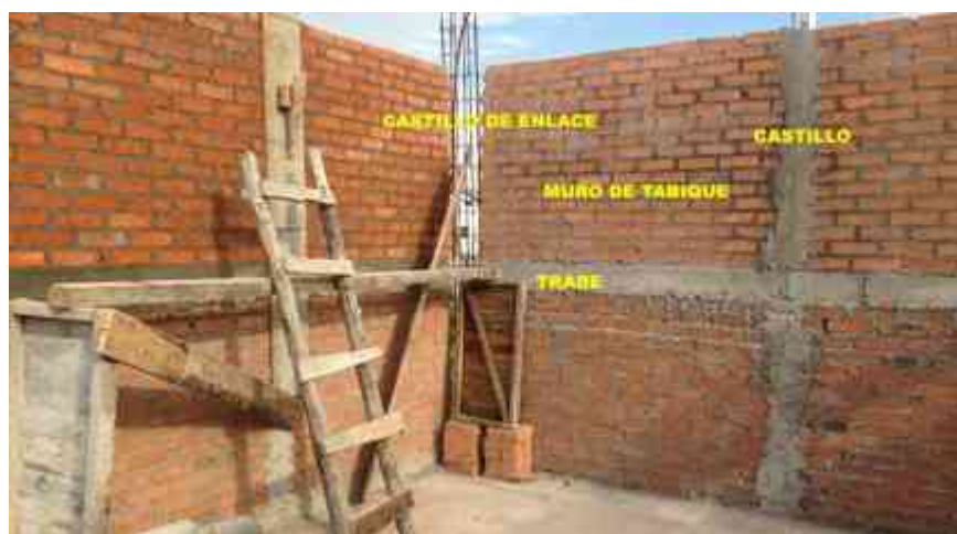
Img. 163 obra casa residencial, fuente: imagen propia del autor. Junio 2017
