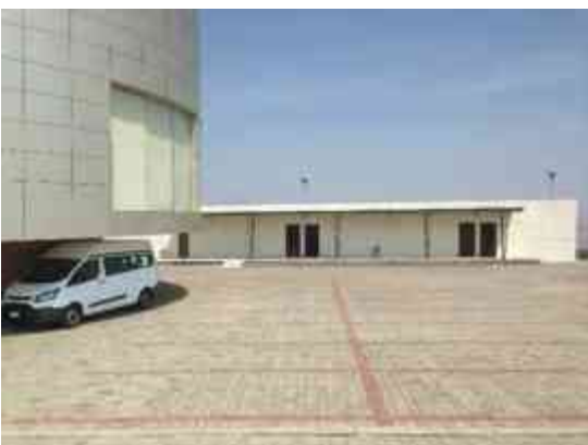
Img. 66 aulas taller del Centro Cultural y de Convenciones Tres Marías, fuente: imagen propia del autor, mayo 2017.
