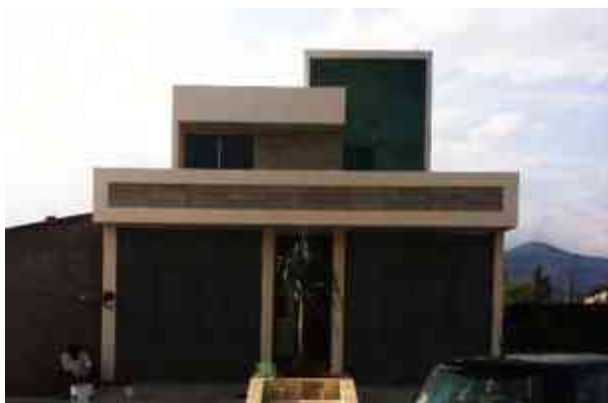
Img. 186 uso de cristal templado en fachada, fuente: Imagen propia del autor.
