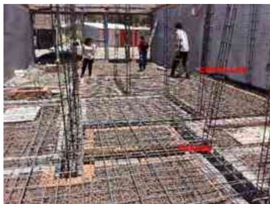
Img. 162 obra casa residencial, fuente: imagen propia del autor. Junio 2017
