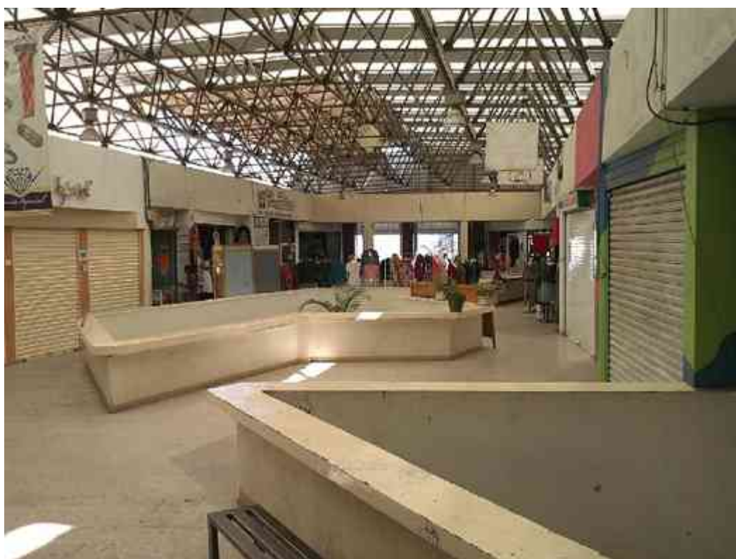
Imagen 5: En la imagen se observa la nave principal, donde se hayan pocos espacios de estancia y descanso, además se muestra que no hay locales en servicio. En la parte superior se aprecia la armadura de acero de tipo tridilosa.
