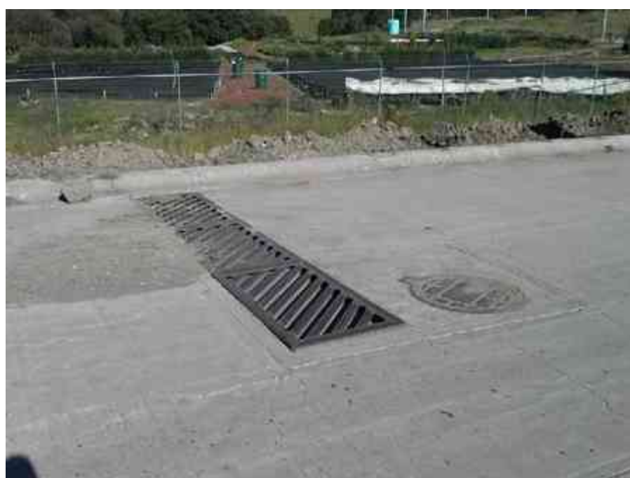
Imagen 4: Alcantarillado en calle pavimentada ubicada en la Avenida Universidad. Fuente: Foto tomada por Diego Patiño Suárez. Año: 2012.
