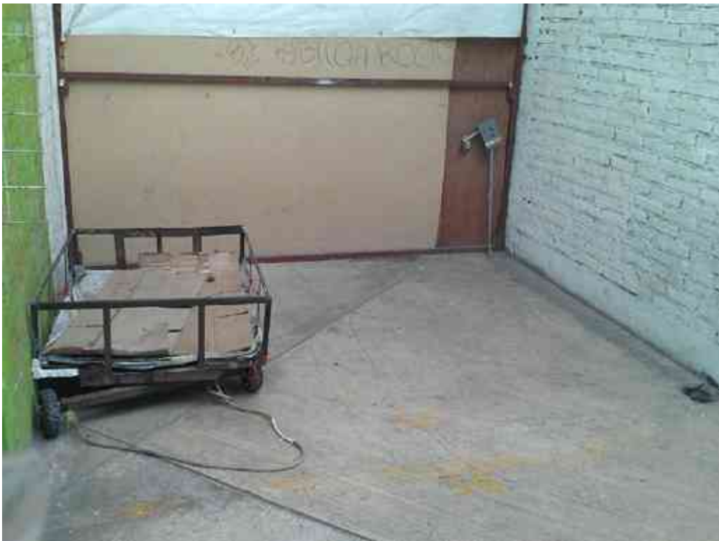
Imagen 10: Local tipo, que se encuentra delimitado por medidas en módulos, se observa que cuenta con una caja de contactos.
