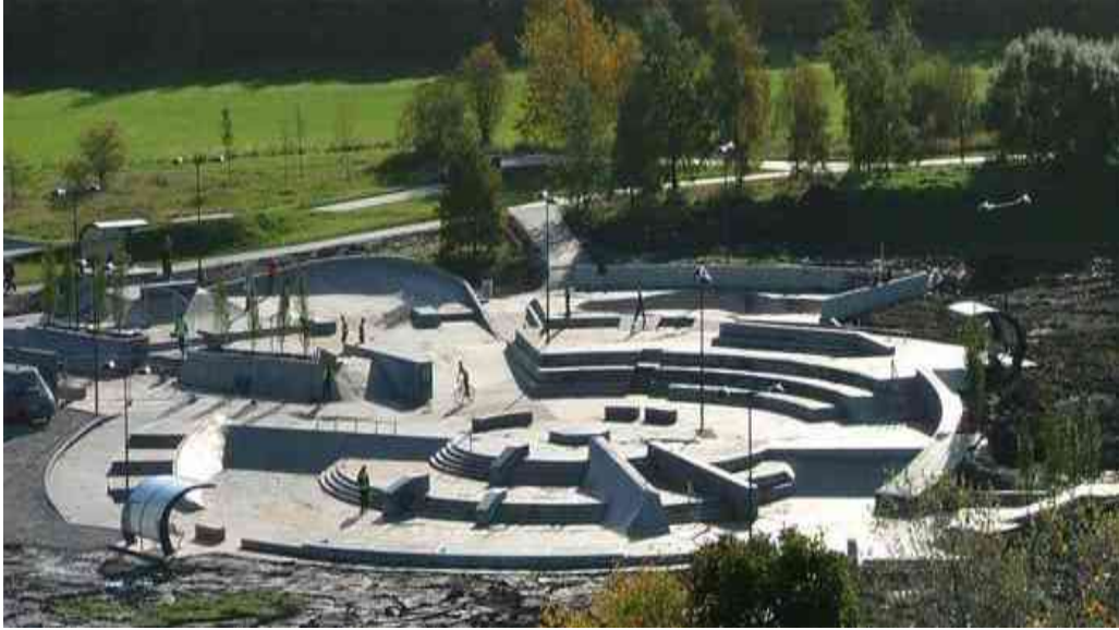
Imagen 5: Pista de patinaje con elementos de rampas y escalones de concreto para mayor resistencia en cuanto a su función.
