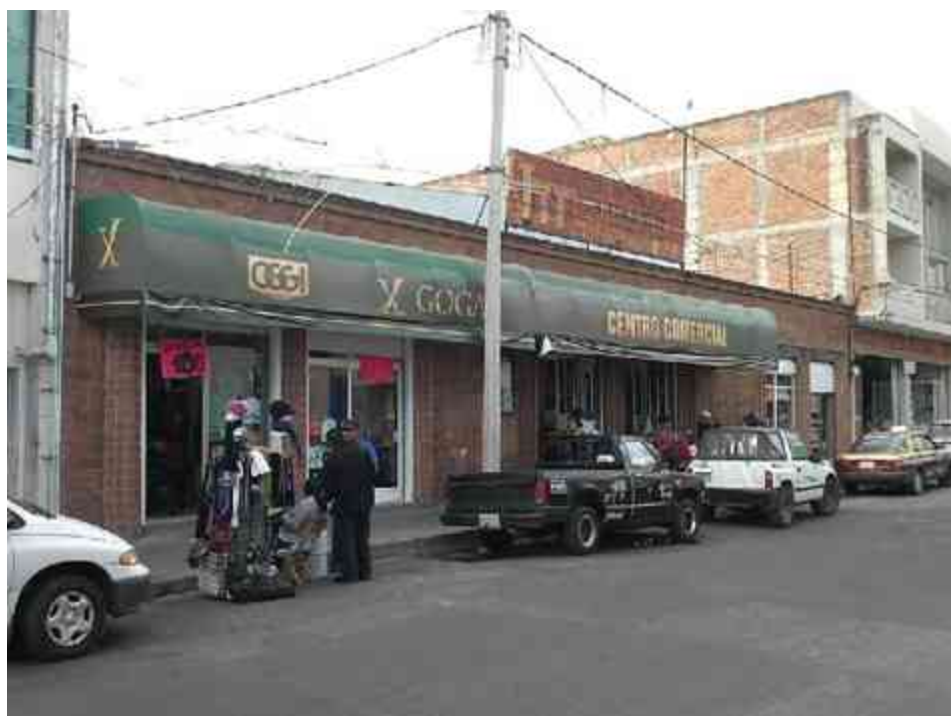
Imagen 1: Fachada principal del Centro Comercial, ésta presenta una imagen deteriorada y carece de un estilo arquitectónico relevante.
