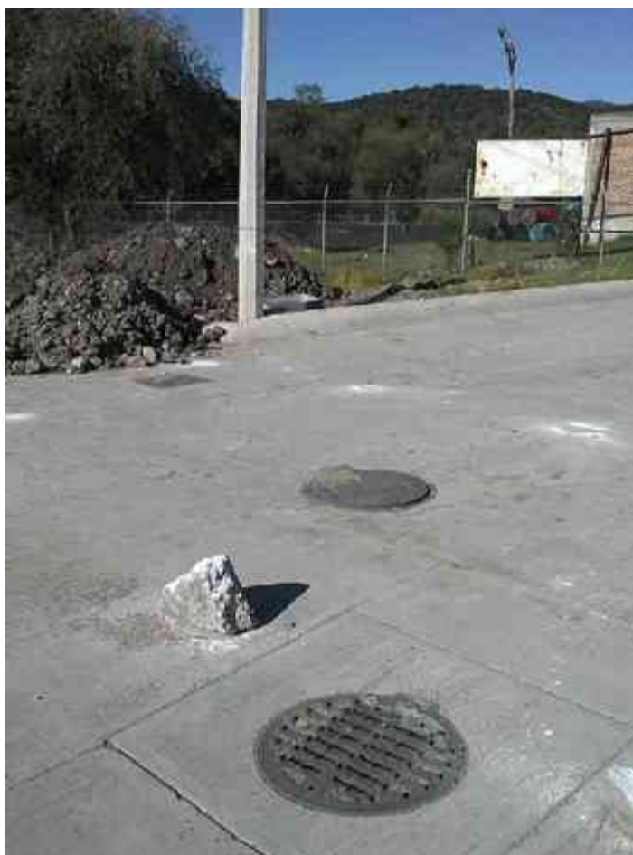
Imagen 6: Servicio Potable y Alcantarillado sobre la calle Oyamel esquina con Avenida Universidad. Fuente: Foto tomada por Diego Patiño Suárez. Año: 2012.
