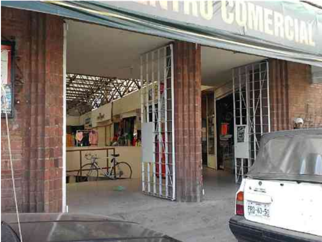
Imagen 2: Acceso Principal al Centro Comercial, se muestran algunos detalles como las puertas de seguridad, además de algunos locales que se encuentran en uso actual, y de armaduras estructurales de tipo tridilosa.
