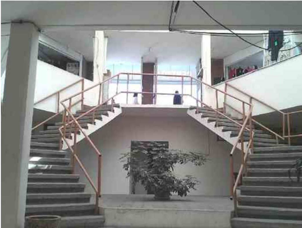
Imagen 6: En el acceso principal existe un desnivel que está conectado por una circulación vertical escalonada la cual lleva a los locales subterráneos.
