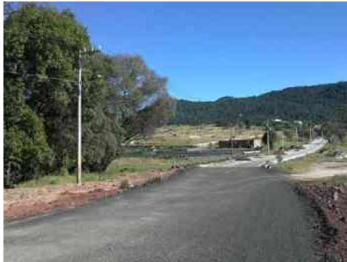
Imagen 6: Vista desde la Avenida Universidad hacia el predio, se observar el contexto inmediato. Fuente: Diego Patiño Suárez. Año: 2012.
