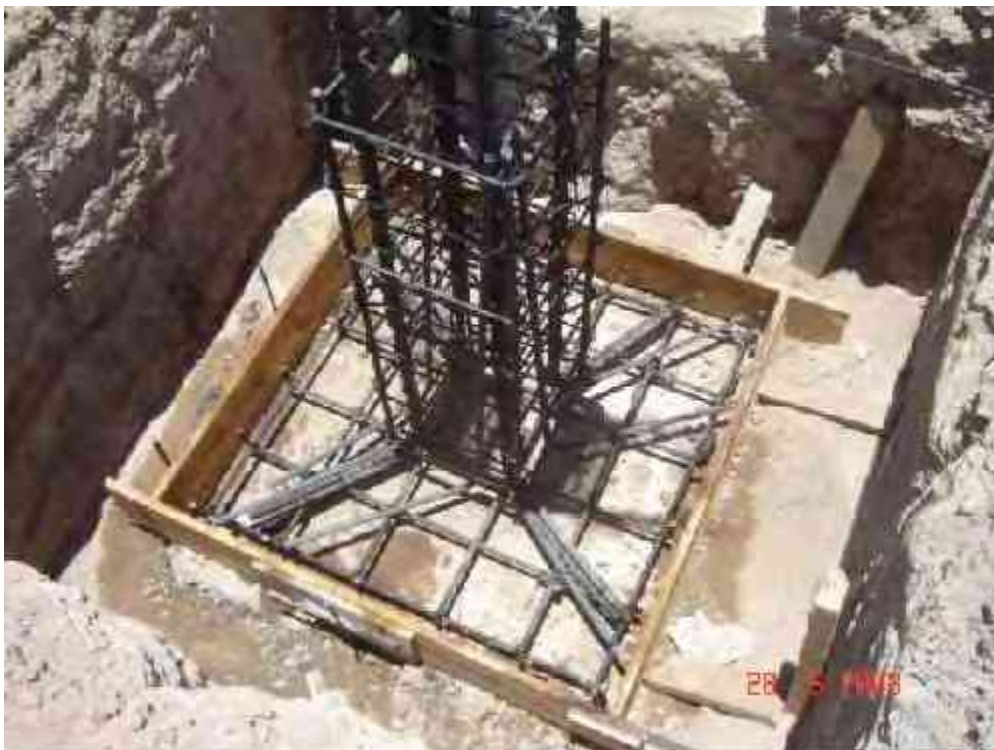
Ilustración 24. Zapatas aisladas
