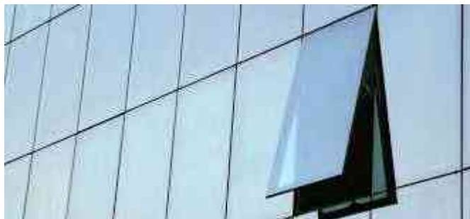
Ilustración 28. Muro de Cortina de cristal
