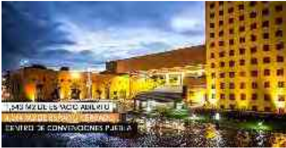
Ilustración 39. Centro de Convenciones de Puebla. Arq. Javier Sordo Madaleno
