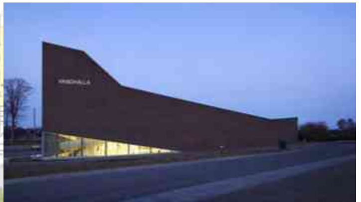
Imagen 7.15.- Imagen de la fachada
