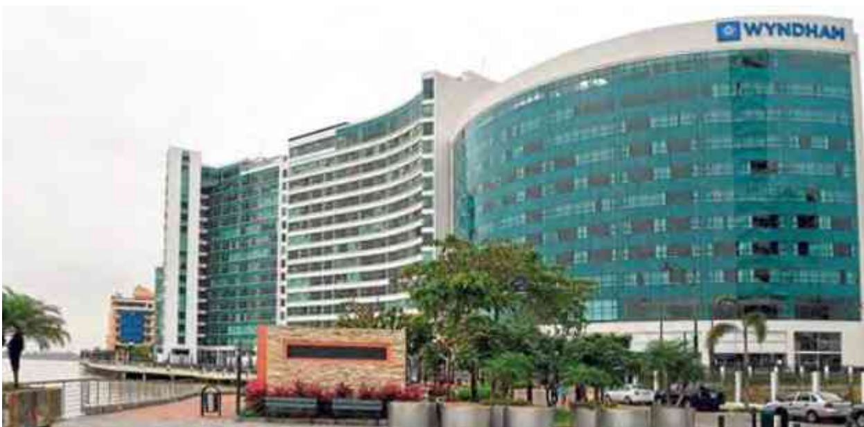
Imagen 7.1.- Muros curvos en la fachada
