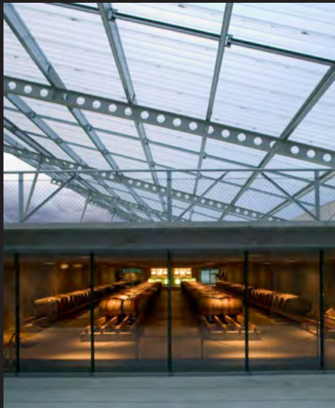
60. Fotografía "Cavas". Divisare.com
