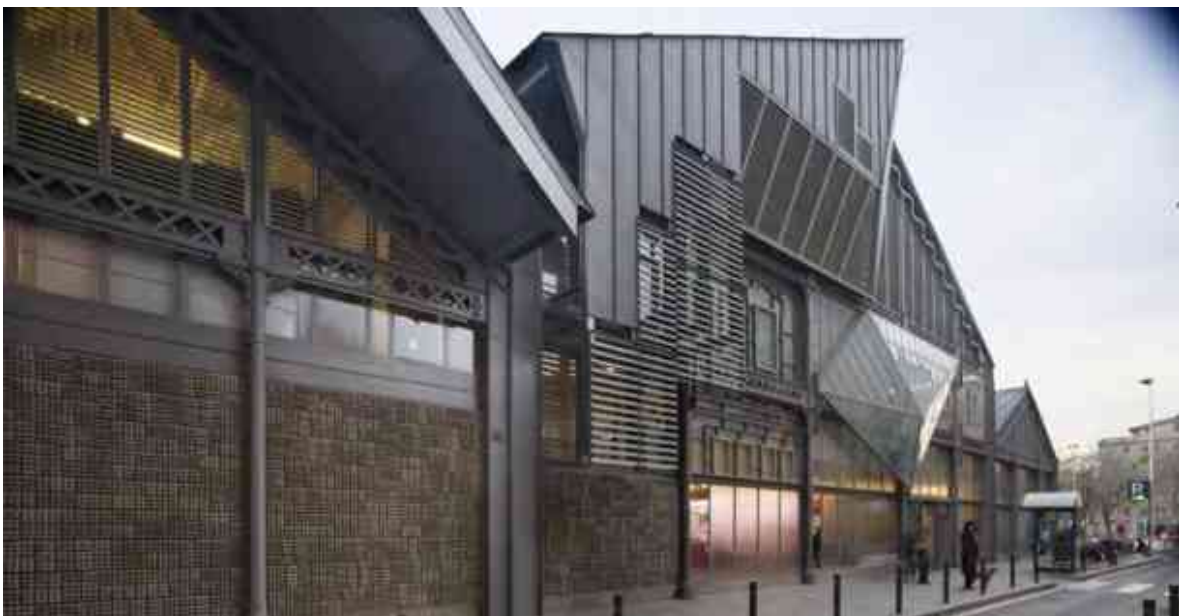
Imágen 26. Fachafa Secundaria. http://www.archdaily.mx/mx/02-92537/mercado-barceloneta-mias-arquitectes/512ac6d1b3fc4b11a700a139-mercado-barceloneta-mias-arquitectes-foto
