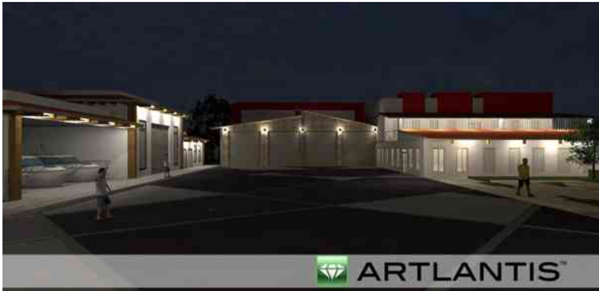
Fachada sureste Nocturno.
