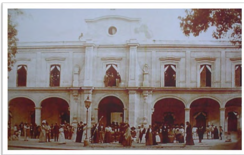
Figura 4. Vista del palacio Municipal de Ciudad Hidalgo. Donde se observa una fachada colonial.
