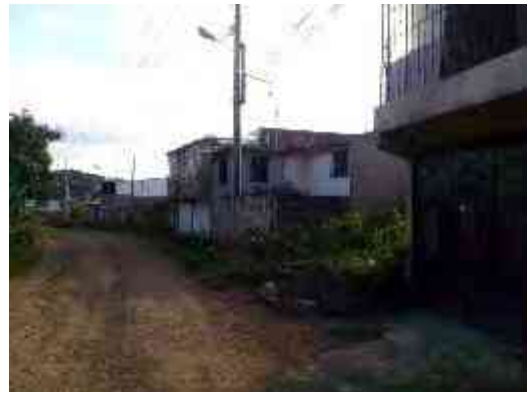
Imagen 17, irregularidad de viviendas. Fotografía tomada en sitio
