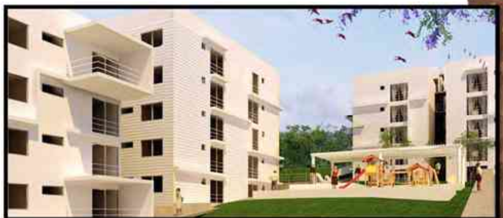
Imagen 7.16 Fachada de torre habitacional y zona recreativa Villa Panamericana
