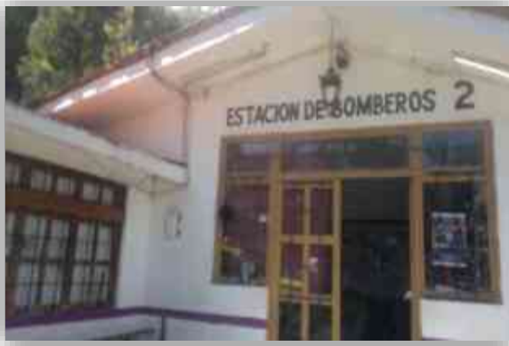
Imagen 12. Entrada principal, estación de bomberos No 2 Morelia Michoacán, Fuente: propia 2016.
