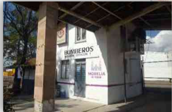
Imagen 8. Acceso principal a la estación de bomberos No 1 Morelia Michoacán, Fuente: propia 2016
