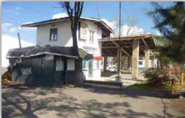
Imagen 7. Estación de bomberos No 1 Morelia Michoacán, Fuente: propia 2016
