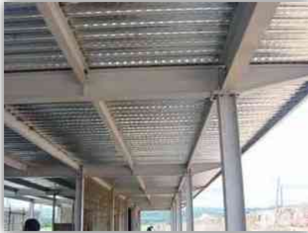
Imagen 123.sistema a base de losa-cero. Fuente: http://www.arqhys.com/articulos/losacero.html
