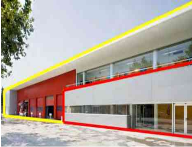
Imagen 83. Parte de la fachada matarao, fuente: http://www.archdaily.mx/mx/02-168516/parque-de-bomberos-de-mataro-jordi .
