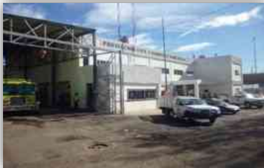
Imagen 47. Parte de la fachada y nave de los camiones, fuente: propia.
