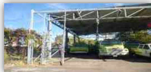
Imagen 51. nave de parqueo, fuente: propia
