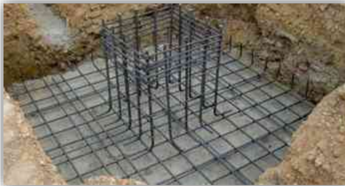
Imagen 121. Zapata aislada Fuente: http://www.civilexcel.com/2013/01/diseño-de-zapata-aislada-aci-308-05.html .
