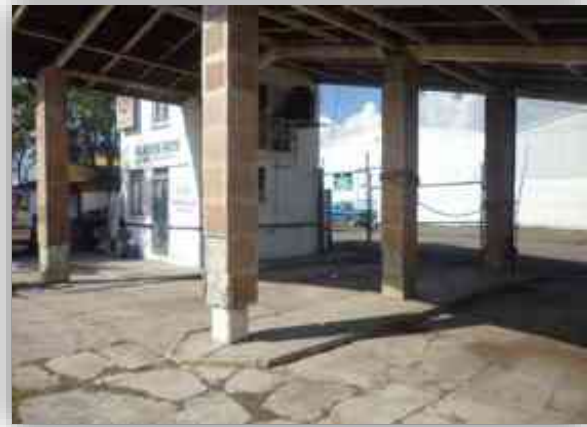
Imagen 10. Parqueo de camiones, estación de bomberos No 1 Morelia Michoacán, Fuente: propia 2016.
