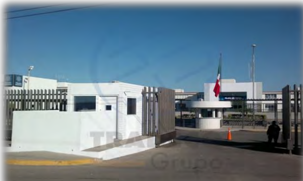
Imagen 45. Entrada al Estacionamiento Estación de Policía de Culiacán. Fuente http://www.tradeco.com/proyectos/EstacionCuliacan/ (Última consulta: 10 de enero de 2017).
