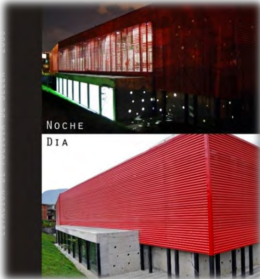
Imagen 49. Fachada posterior de la Estación de Policía de Belén Medellín. Fuente http://www.archdaily.co/co/02-130063/estacion-de-policia-belen-edu (Última consulta: 10 de enero de 2017).
