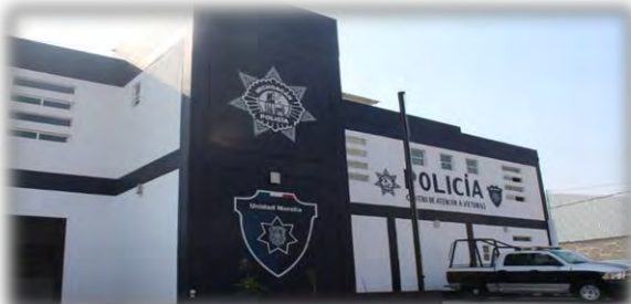
Imagen 47: Estación de Policía de la colonia Aquiles Cerdán en Morelia Mich. Fuente: M.F.V.A, fecha: 15 de enero de 2017.
