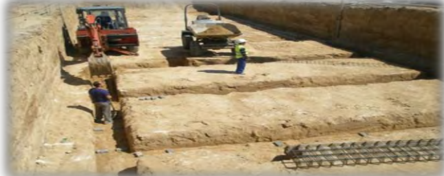
Imagen 81. En esta imagen se observa la excavación que se realiza para la cimentación. Fuente: http://www.bayona.es/1122-8%20viviendas%20adosadas%20en%20arroyomolinos/1122-8-viviendas-adosadas-en-arroyomolinos.html . Última Consulta: 14 de enero de 2017.
