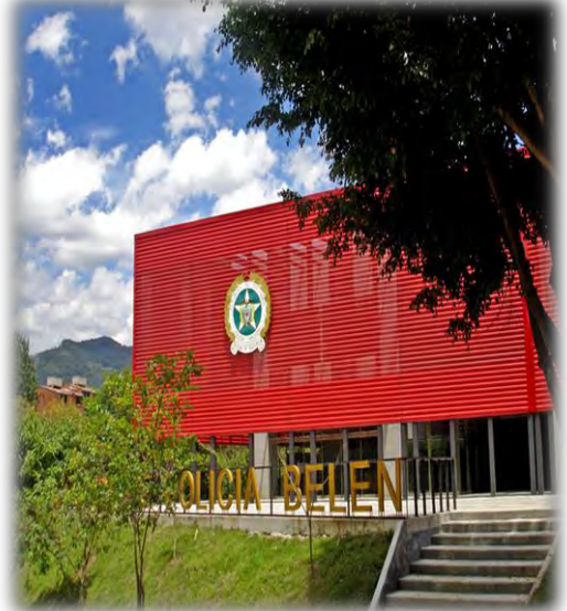
Imagen 50. Fachada frontal de la Estación de Policía en Belén Medellín. Fuente http://www.archdaily.co/co/02-130063/estacion-de-policia-belen-edu (Última consulta: 10 de enero de 2017).
