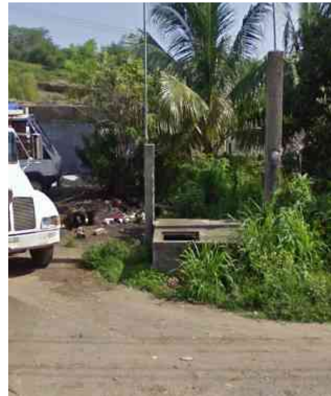
Figura 46. Toma de agua potable. 2016 (Fuente: Autor).
