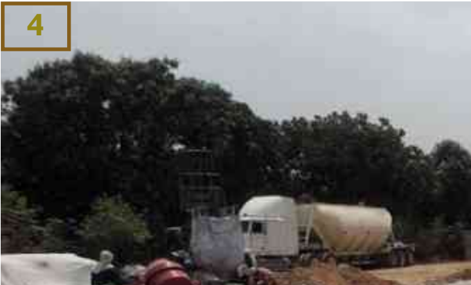
Figura 43. Vista al este del terreno. 2016 (Fuente: Autor).
