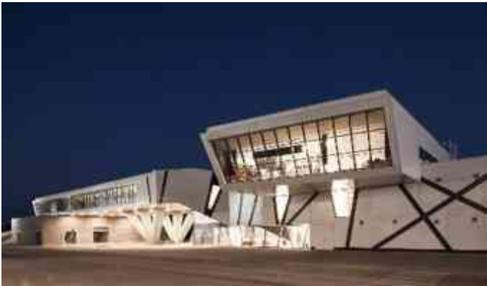
Figura 50. Área administrativa, Planta de cemento Strabag. 2013 (Fuente: Plataforma de arquitectura).
