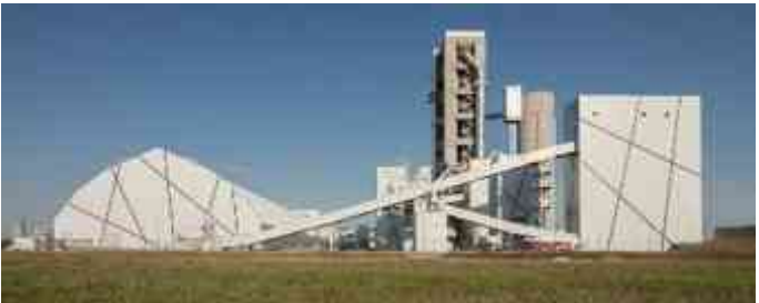
Figura 52. Vista lateral de conjunto, Planta de cemento Strabag. 2013 (Fuente: Plataforma de arquitectura).
