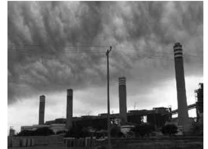
Figura 10. Termoeléctrica Petacalco. (Fuente: Marco Antonio Gallardo).
