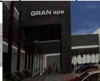
Imagen #41 - Fachada del inmueble - www.google.com.mx/maps
