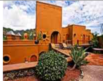
Imagen #32 - Fachada del inmueble - www.google.com.mx/maps
