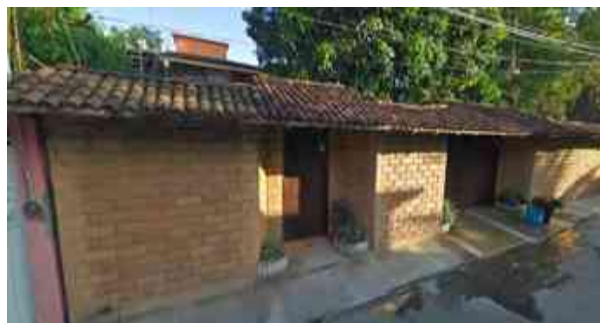
Imagen #38 - Fachada del inmueble - www.google.com.mx/maps
