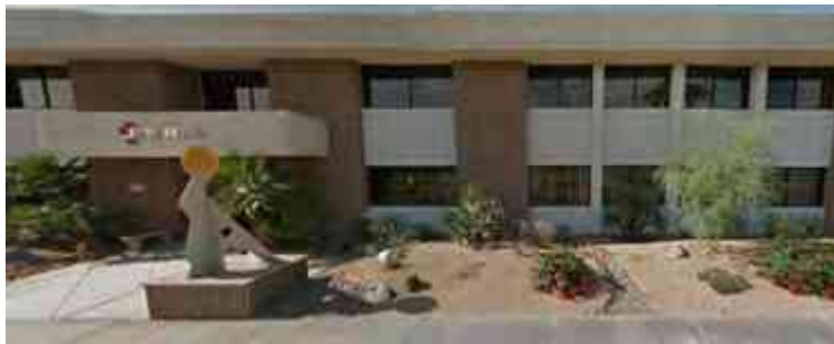
Imagen #21 - Fachada del inmueble - www.google.com.mx/maps
