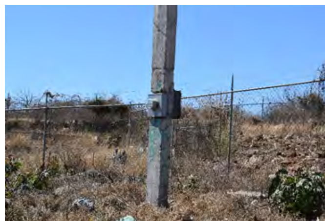
Ilustración #26 . Mufa de predio. Edición propia.
