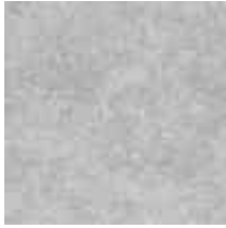
Firme de concreto pulido.
