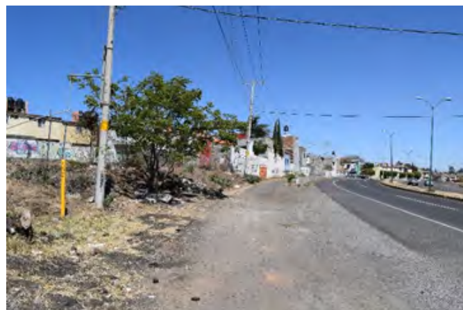
Ilustración #24. Vialidad pavimentada e instalación. Toma y edición propia.
