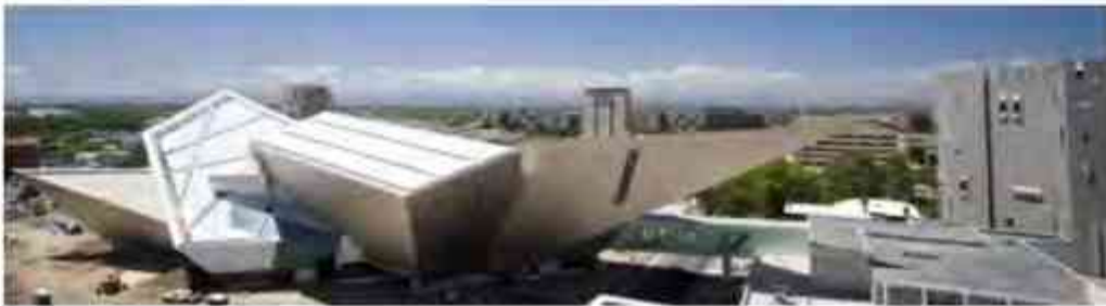
Fotografía 4 Edificio Frederic C. Hamilton © Bitter Bredt
