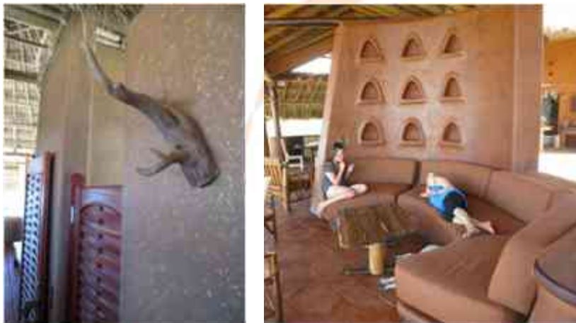
IMAGEN 43. EJEMPLO DE ACABADO CON MEZCLA DE TIERRA. FUENTE: LEWIS, MICHEL. (2011). ARQUITECTURA SUSTENTABLE. RECUPERADA DE: http://arquitecturasustentable.com.mx/aplanados-con-tierra/
