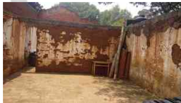
IMAGEN 31: CONDICIÓN ACTUAL DEL INTERIOR DEL PREDIO. FUENTE: PROPIA.
