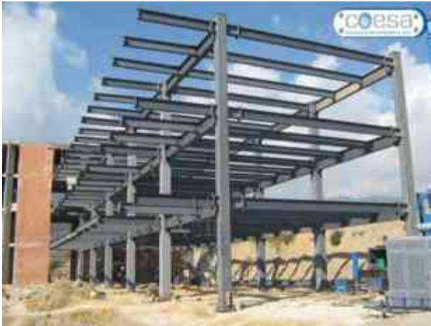
Imagen 32: elementos de acero estructural.
