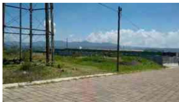
Imagen 40: Fotografía del predio desde calle José Manuel de Jesús, hacia el sur donde se observa el tanque elevado que se encuentra en el terreno y al lado del terreno se encuentra una guardería del H. Ayuntamiento. Fuente: A.P.S
