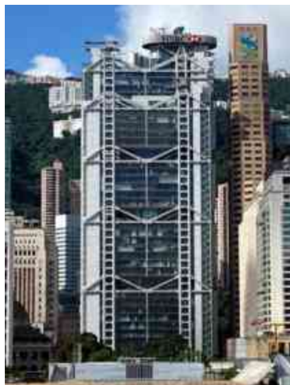
Imagen 22: La Sede central del HSBC (Hong Kong) de Norman Foster, es un ejemplo de arquitectura High Tech.
