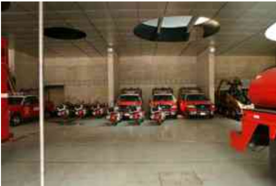
Imagen 25: Interior de la estación, patio de maniobras y estacionamiento de bombas.
