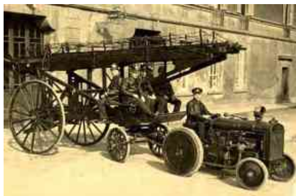
Imagen 6: Escalera, arrastrada por un tractor.
