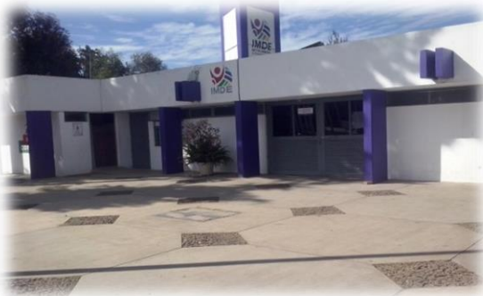
Fig.13. Módulos de sanitarios Fuente: MACR
