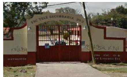
Fig .64.Fachada de la Telesecundaria 393, ubicada a 700 mts del terreno. Fuente; Internet Google Earth
