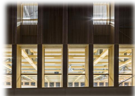
Fig.31. Muestra las columnas y sus paneles de vidrio Fuente: Fotógrafo: Sergio Grazi
