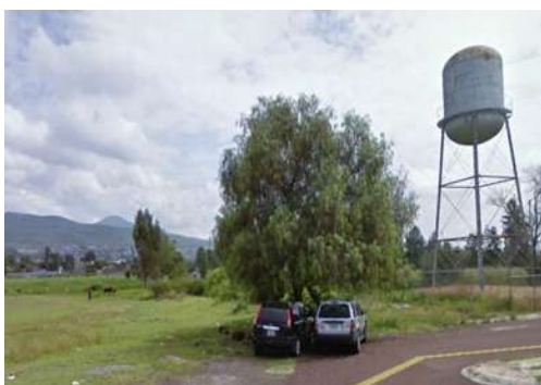
Fig 58. Servicio de agua potable, Fuente: MACR,
