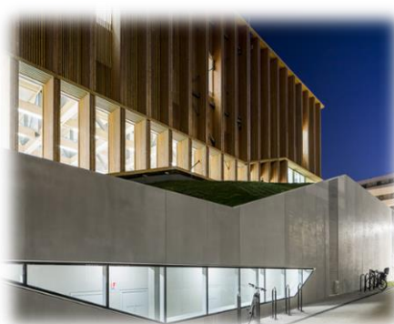
Fig.34.Muestra la ubicación de la sala de calderas, calefacción y aire acondicionado Fuente: Fotógrafo: Sergio Grazi
