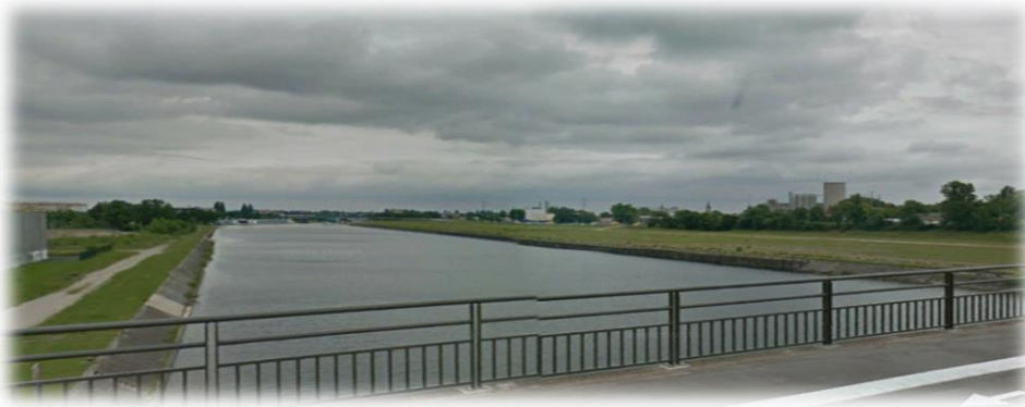
Fig.27. Muestra canal de agua Fuente: Internet
