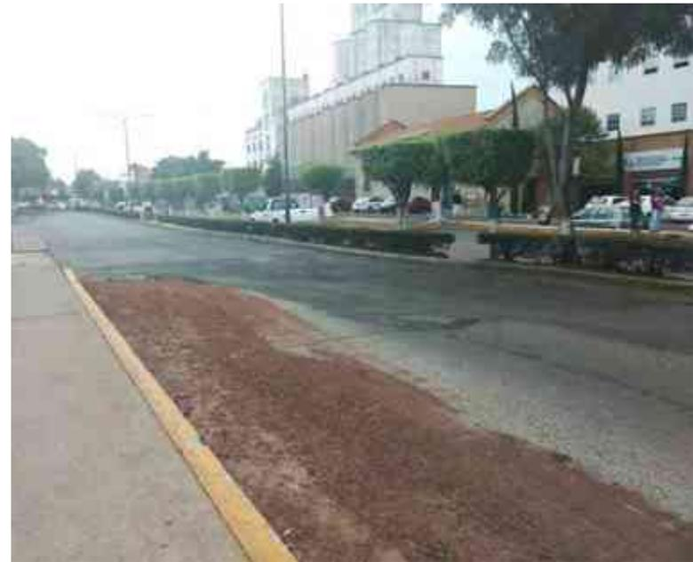
Imagen 14, Relleno de grava roja en hundimiento ocasionado por falla geológica en la Av. Héroes de Nocupétaro. Fotografía AMFM
