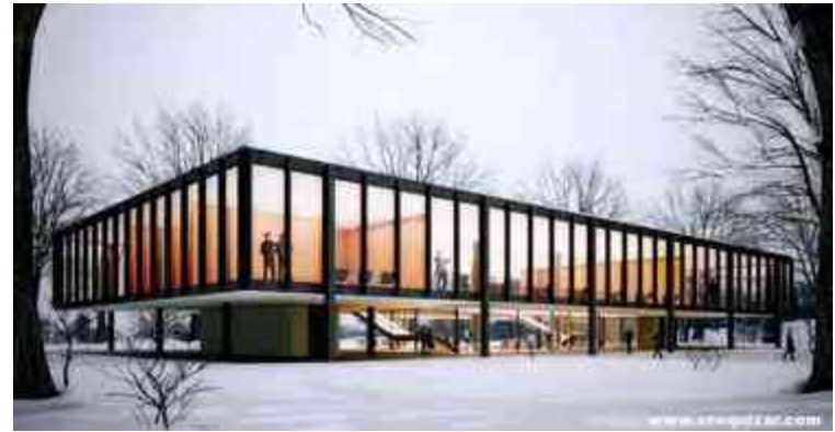
Imagen 32. Vista en perspectiva del edificio Bacardi en México
