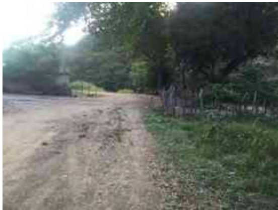
Imagen 06: tramo 2. Deterioro de vialidades. Fotografía: 20/09/16
