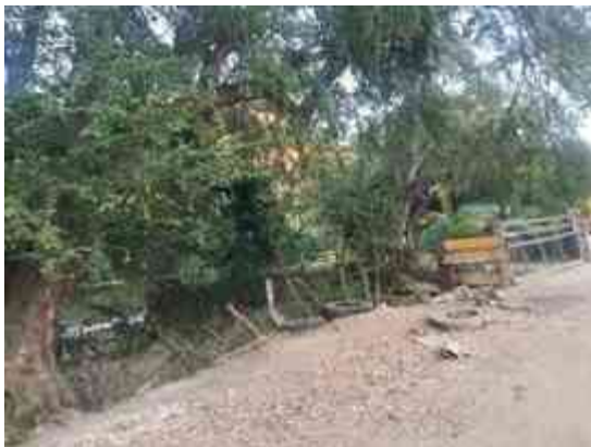
Imagen 07: tramo 3. Construcción de espacios para fines propios. Fotografía: 20/09/16
