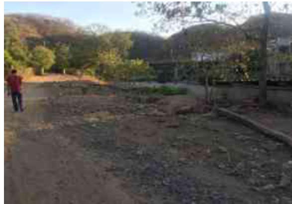
Imagen 04: tramo 1. Deterioro de vialidades. Fotografía: 20/09/16
