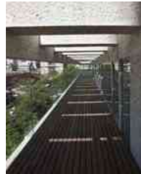
Figura.14. Interior, pasillo que da a la fachada exterior
