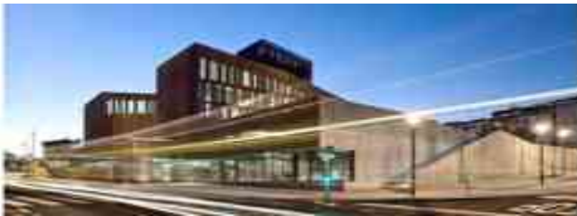
Ilustración 30, Fachada Principal, casa de la cultura Oke, Ortuella Bilbao
